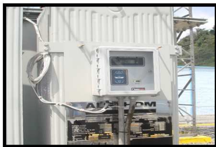
Figura 5.15. Instalación del equipo en campo.
