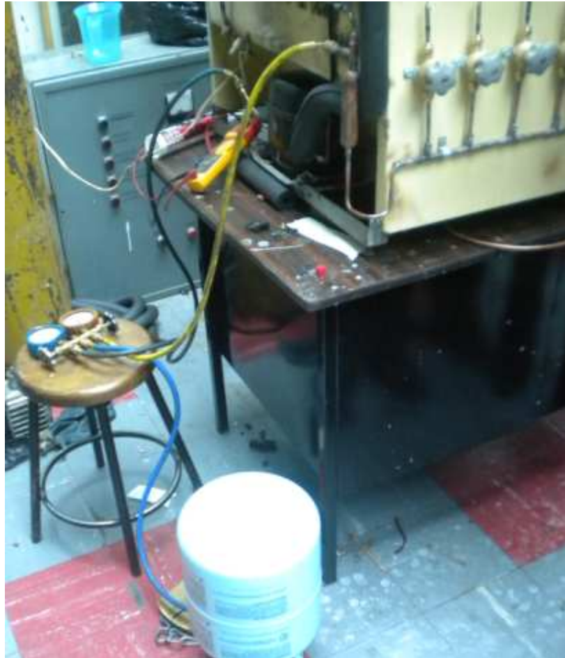
Figura 5.13. Carga de refrigerante R-134a
