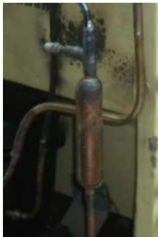
Figura 5.14. Filtro secador para el R-290
