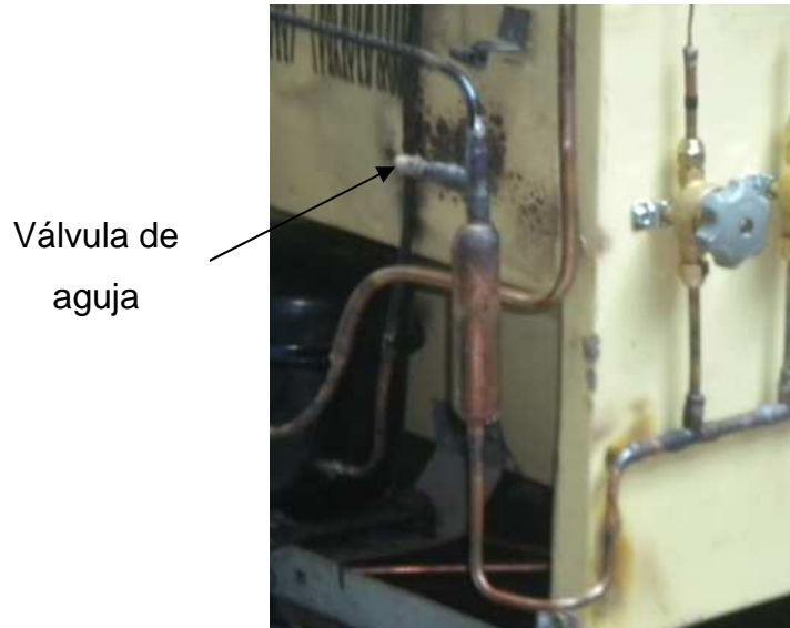
Figura 5.8. Válvula de aguja en la zona de alta
