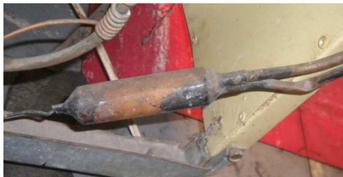
Figura 5.5. Filtro original del equipo a ser reemplazado
