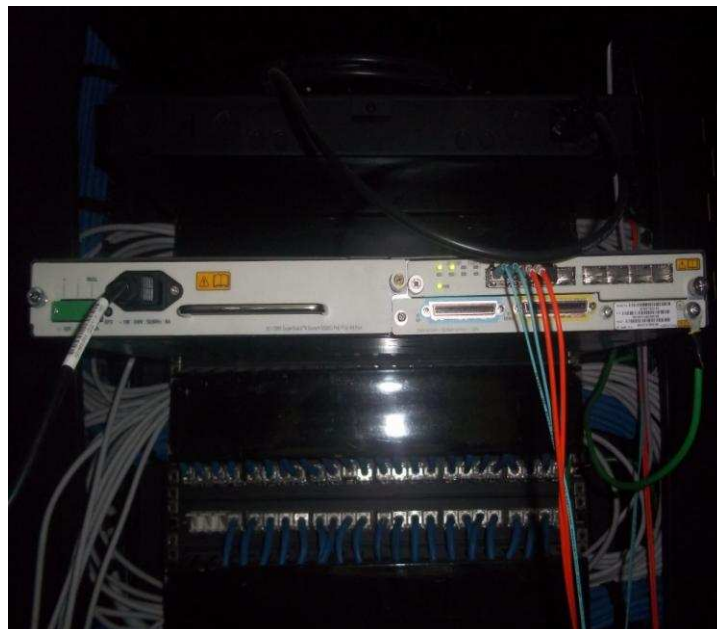
Gráfica 15 Conexión de la Fibra Óptica Realizado por Armando Palaquibay
