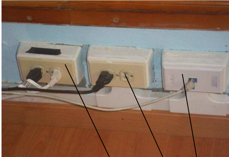
Gráfica 14 Cableado Tomas Eléctrico Regulado, Normal, Datos Realizado por Armando Palaquibay
