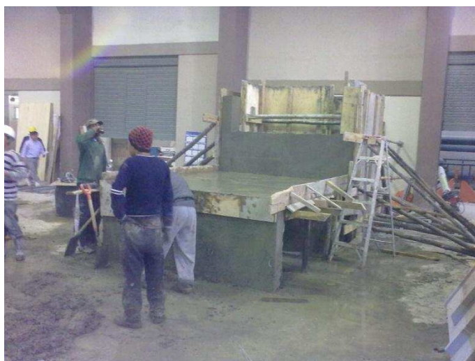
Fotografía No. 2: Construcción del tanque de abastecimiento para el embalse Toachi.
