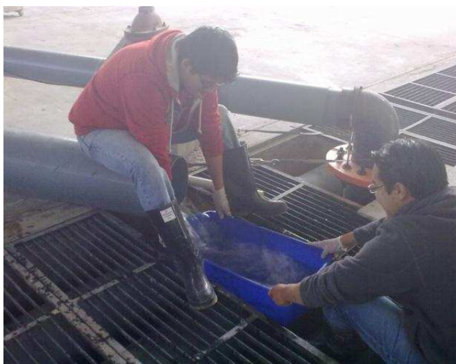
FOTOGRAFÍA No. 5.22: Calibración volumétrica de los vertederos de medida.
