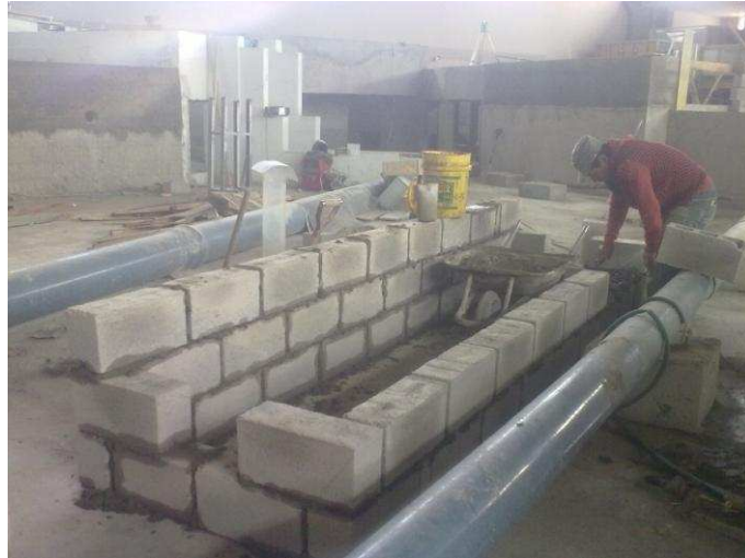
Fotografía No. 3: Construcción del canal de descarga del modelo.
