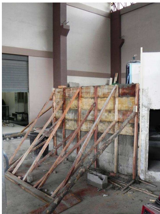
Fotografía No. 1: Fundición de pared de tanque de abastecimiento al túnel de descarga Sarapullo.
