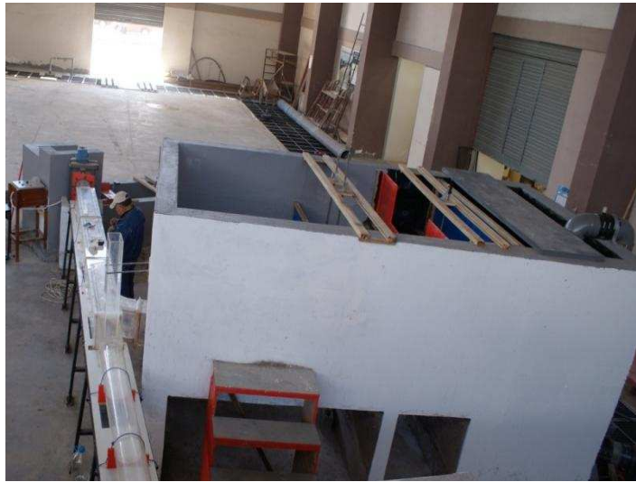
FOTOGRAFÍA No. 5.7: Vista lateral del tanque de abastecimiento Presa Toachi.
