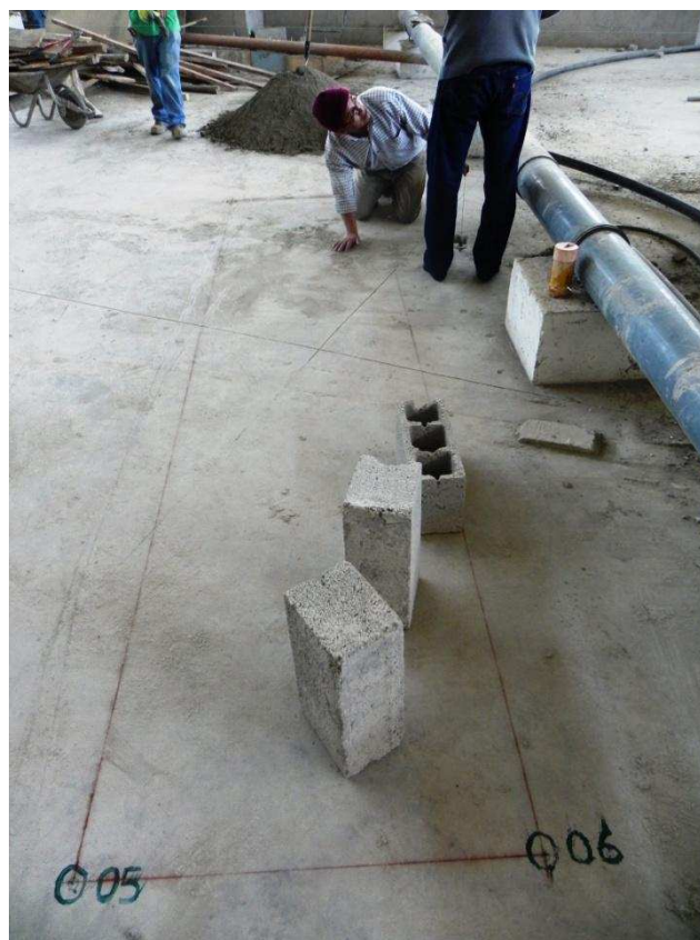
FOTOGRAFÍA No. 5.1.- Replanteo Tanque de Descarga.
