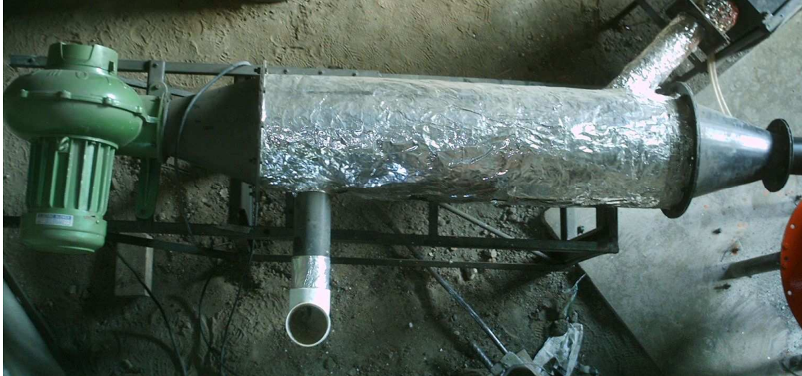
Figura 5.3. Montaje del intercambiador de calor
