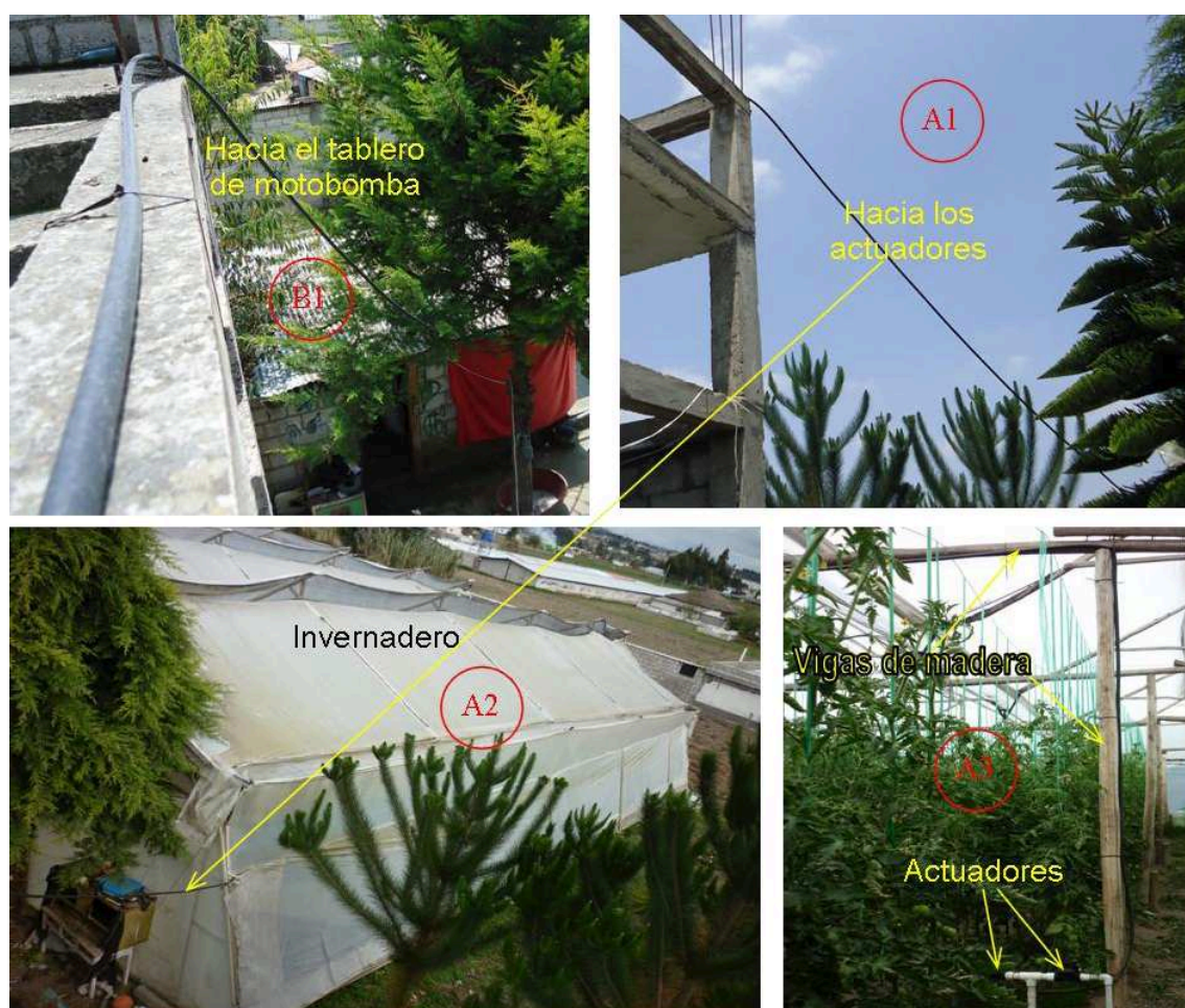
Figura 2.17 Fotografías: tendido tuberías hacia los actuadores y tablero de motobomba 62
