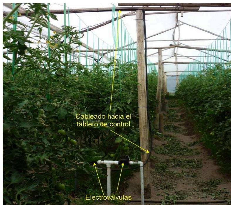
Figura 2.44 Disposición del cableado de electroválvulas 83
