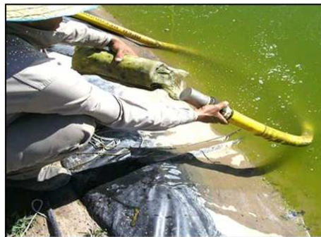
Figura 1.22 Canasto de protección en la zona de succión
