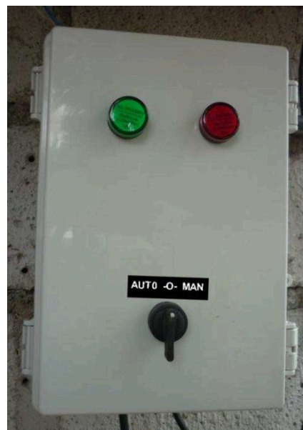
Figura 2.42 Puerta del tablero de motobomba terminado 81
