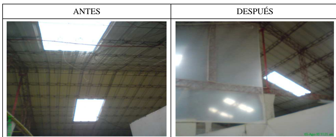
Figura 13. Resultado de la Implementación de BPM's Colocación de protecciones
