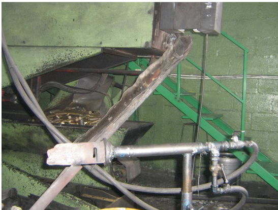
Fig. 7.- Alimentación de trozos cortados
