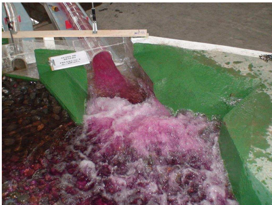
Fotografía No. 44: Imagen superior del flujo en la salida del Túnel de Desvío, ( Q_{TD}=800.00 \text{ m}^3/\text{s} )
