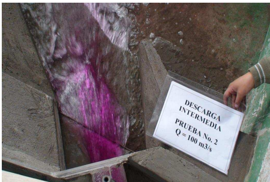
Fotografía No. 51: Vista del flujo de salida de la Descarga Intermedia, ( Q_{DI}=100.00 \text{ m}^3/\text{s} )
