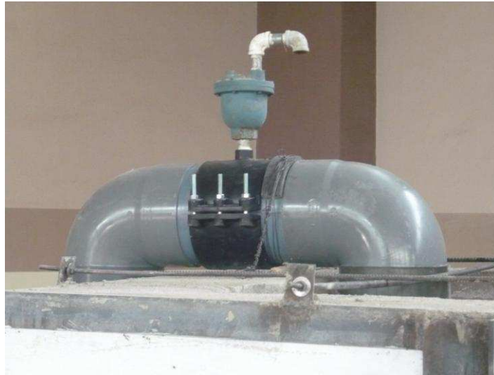
Fotografía No. 8: Instalación de la válvula de aire en la tubería
