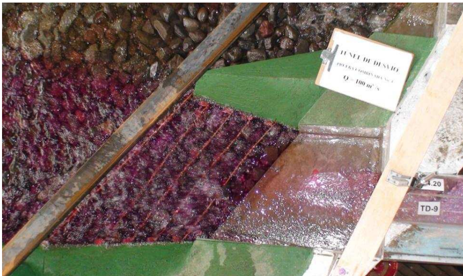
Fotografía No. 59: Vista superior de la estructura de salida del Túnel de Desvío, ( Q_{TD} = 99.55 \text{ m}^3/\text{s} , Q_{DI} = 23.7 \text{ m}^3/\text{s} )
