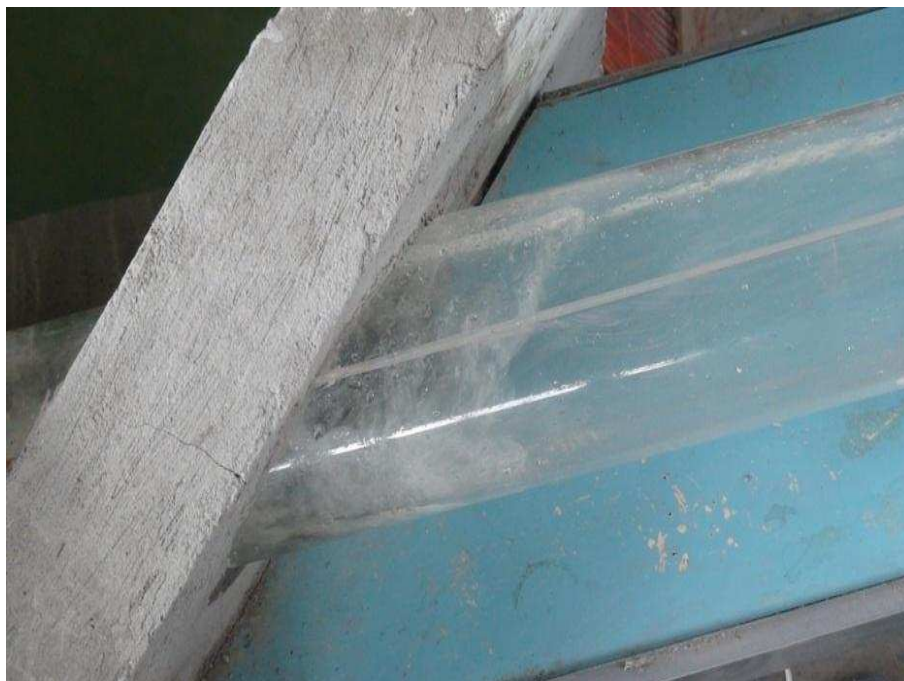
Fotografía No. 16 Inclinación del resalto a la entrada de la estructura de salida
