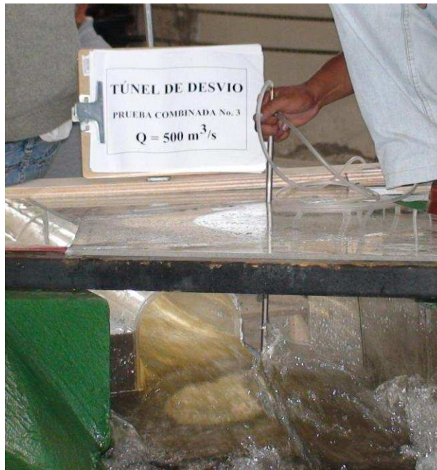
Fotografía No. 71: Toma de medida en el punto 2TD en el Túnel de Desvío ( Q_{TDp} = 502.37 \text{ m}^3/\text{s} , Q_{Dlp} = 151.90 \text{ m}^3/\text{s} )
