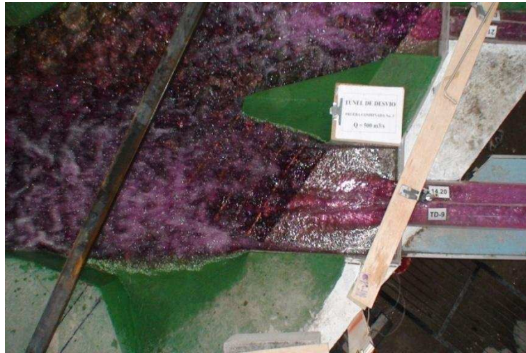
Fotografía No. 51: Vista en planta del funcionamiento de la estructura de salida en el Túnel de Desvío ( Q = 500 \text{ m}^3/\text{s} )
