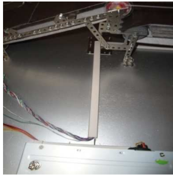
Fig. 2.100 Cables guiados por canaleta.
