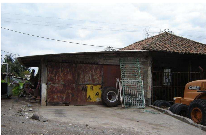
Figura 2.4. Infraestructura del parque de maquinaria 5
