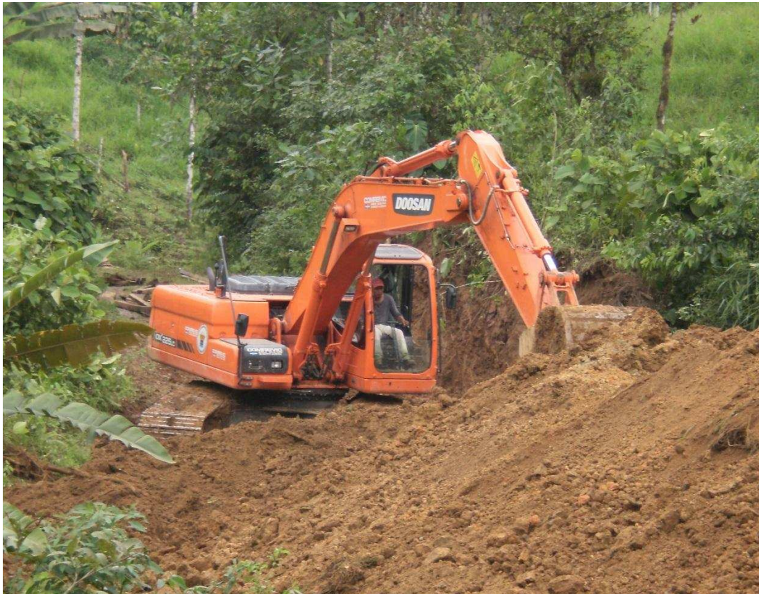
Figura 2.12. Excavadora Doosan DX-225LC 16
