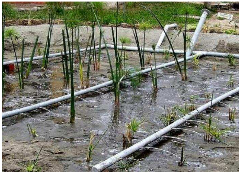
Figura 1.17. Sistema de distribución de agua en un humedal artificial vertical (Hoffman et al. , 2011)
