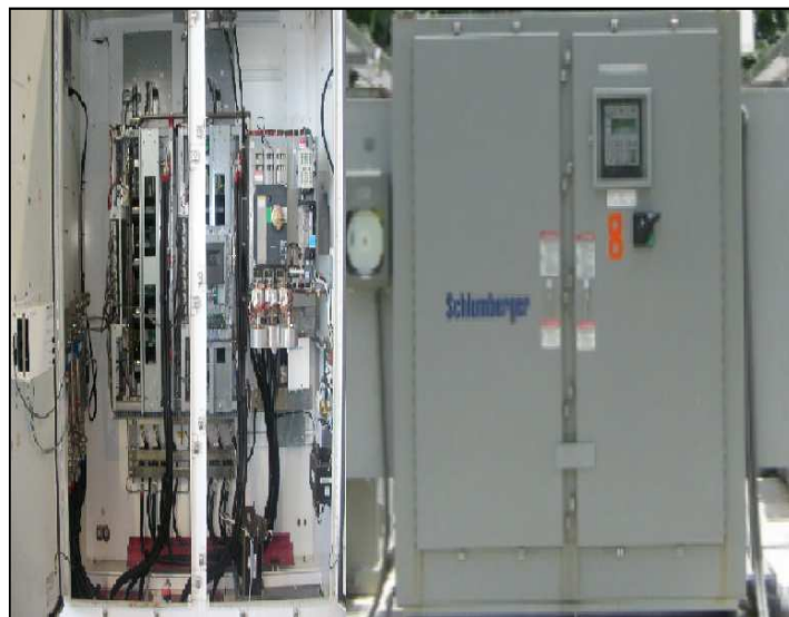
Figura 1.9 VARIADOR DE FRECUENCIA (VSD)
