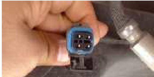
Figura 5.28. Revisión del estado del arnés del sensor. 36
