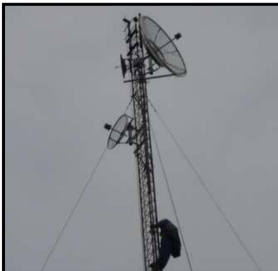
**Figura 3.90: Antenas instaladas en la torre de Oso A.**
