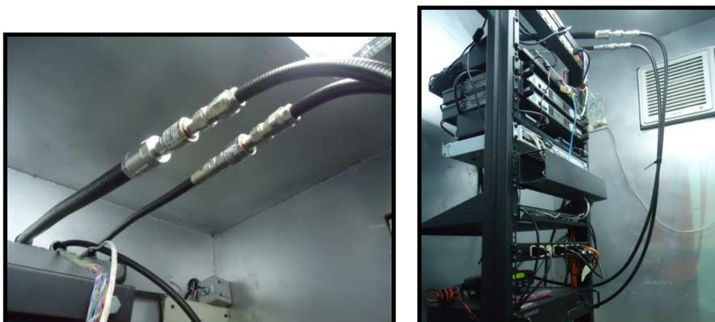
**Figura 3.92: Conexión del Line Arrestor y el Cable Superflex.**
