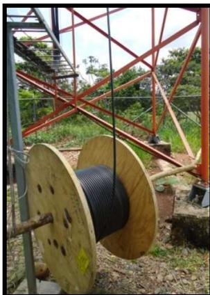
Figura 3.114: Instalación del cable HeliAx de ½".
