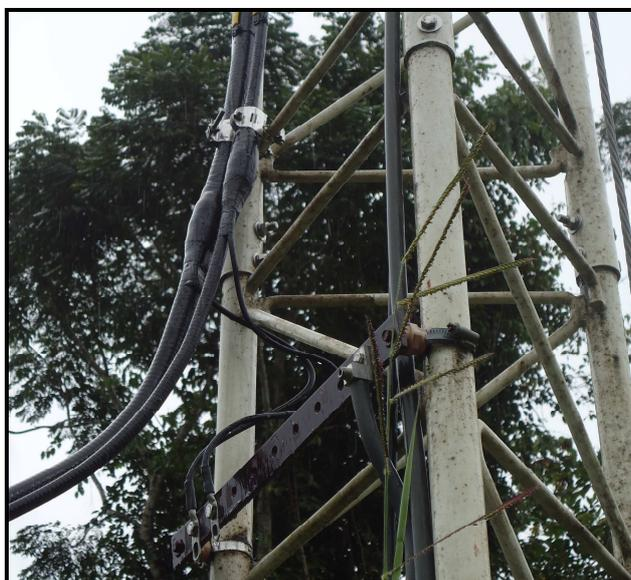
**Figura 3.86: Instalación de los cables, hangers kit, ground kit y etiquetas.**
