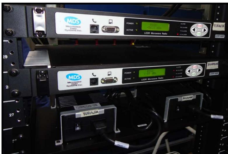
Figura 3.128: Radios MDS instalados en 24 de Mayo.
