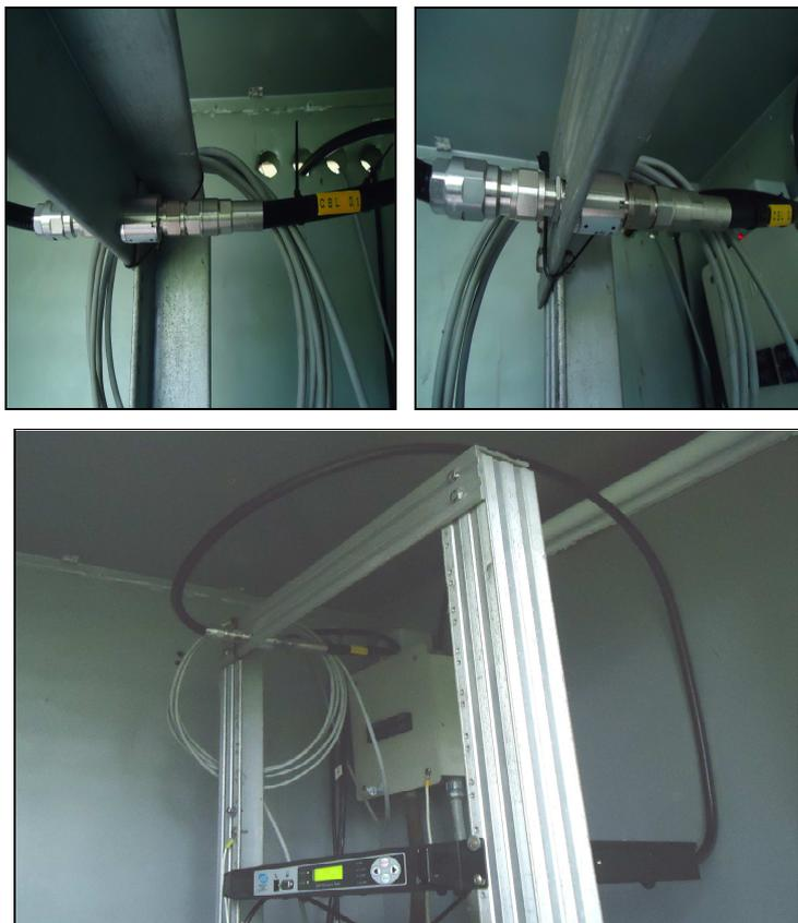
**Figura 3.77: Instalación line arrestor en el rack y cable superflex.**
