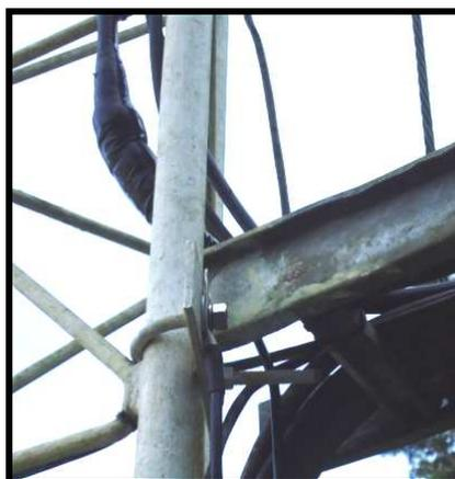
Figura 3.109: Conexión del Ground Kit a la torre.
