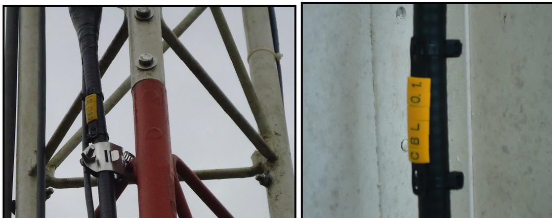
**Figura 3.80: Instalación Cable heliax, hangers kit, ground kit y etiquetas.**
