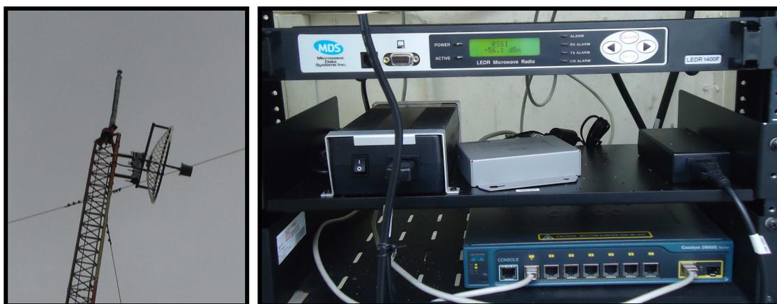
Figura 3.79: Instalación de la antena, el radio MDS y su fuente en el rack.
