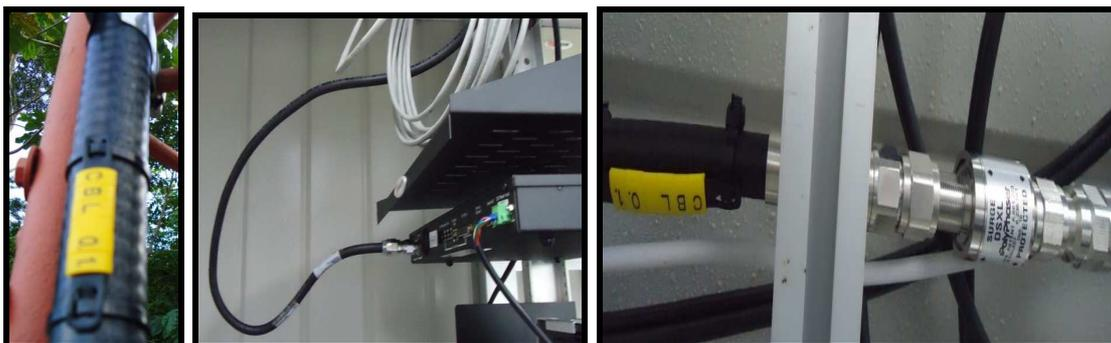
Figura 3.134: Cable Heliax, superflex, hanger Kit, etiquetas y poliphaser en Yuralpa.
