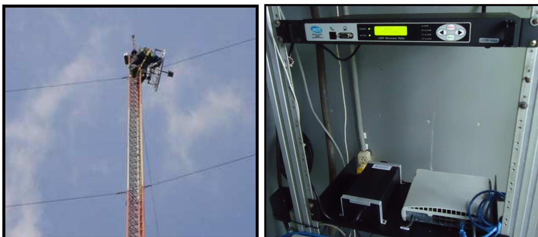
Figura 3.75: Instalación Antena (izq) y Radio MDS con su fuente en el rack (der).
