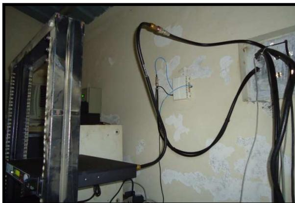
**Figura 3.122: Conexión del cable superflex.**
