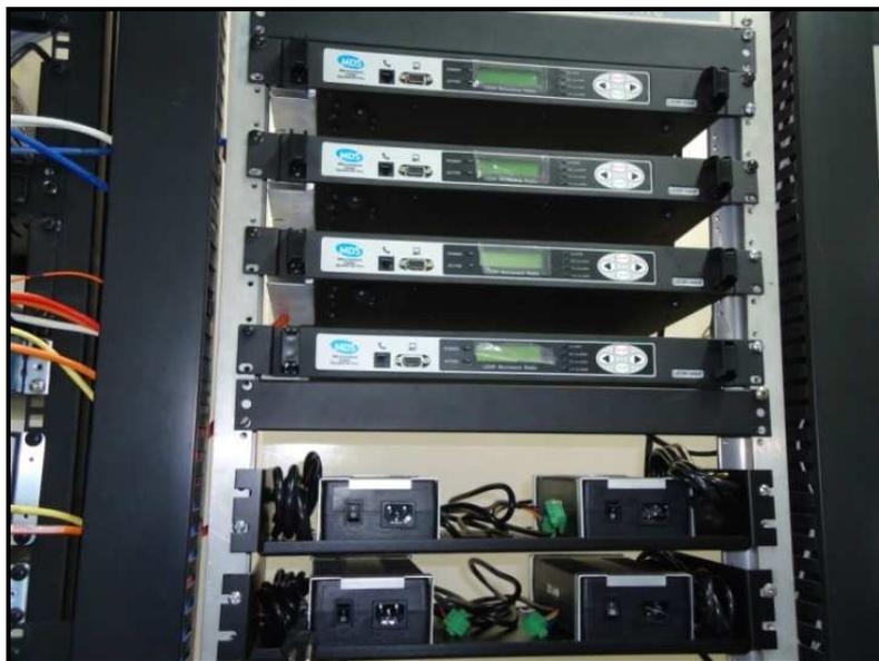
Figura 3.52: Instalación de Radios MDS y sus Fuentes de Poder.
