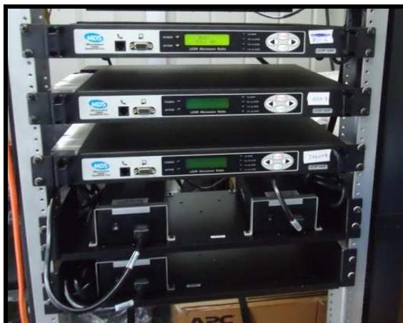
**Figura 3.97: Radios MDS y Fuentes instalados en el rack de Oso A.**
