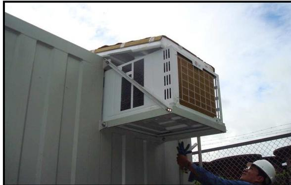
**Figura 2.3: Instalación del aire acondicionado con techo.**
