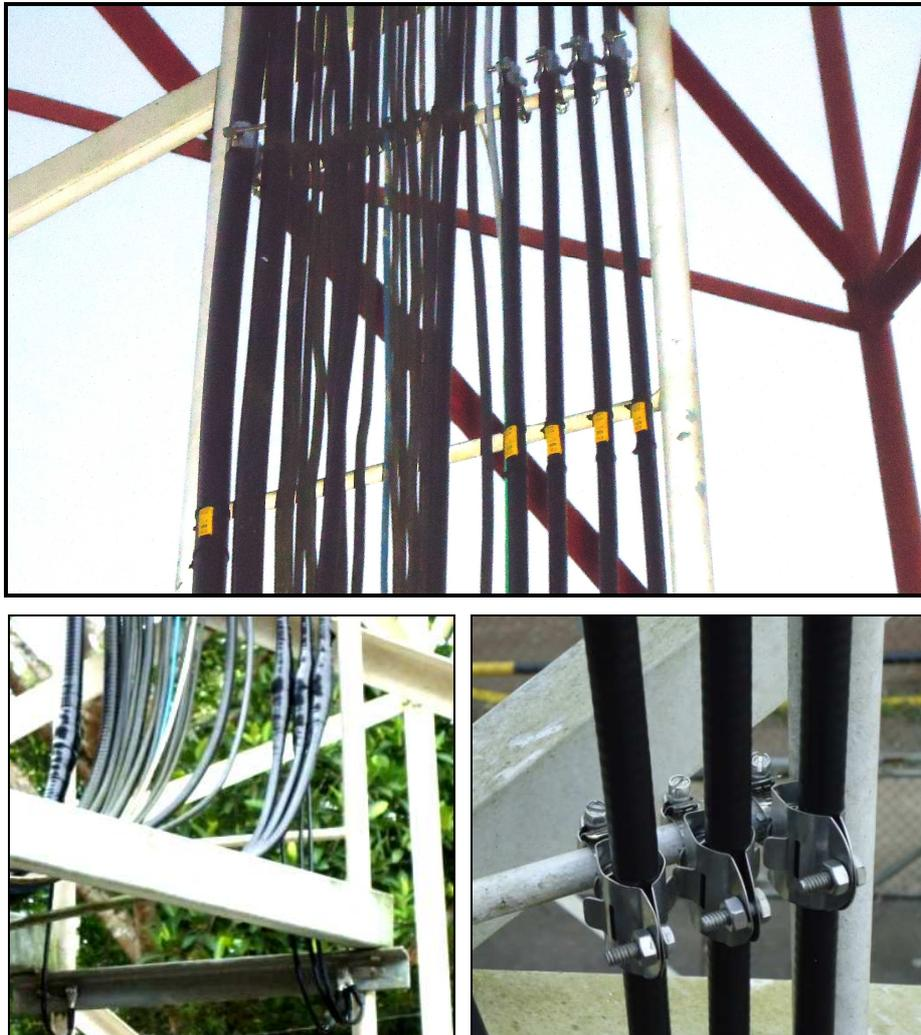
**Figura 3.66: Instalación de cables Heliax, Hangers kit, Ground Kit y etiquetas.**
