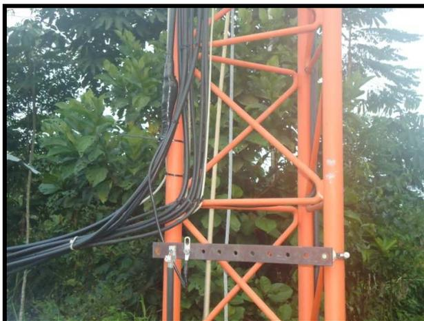
**Figura 3.123: Conexión del Ground kit hacia la torre.**
