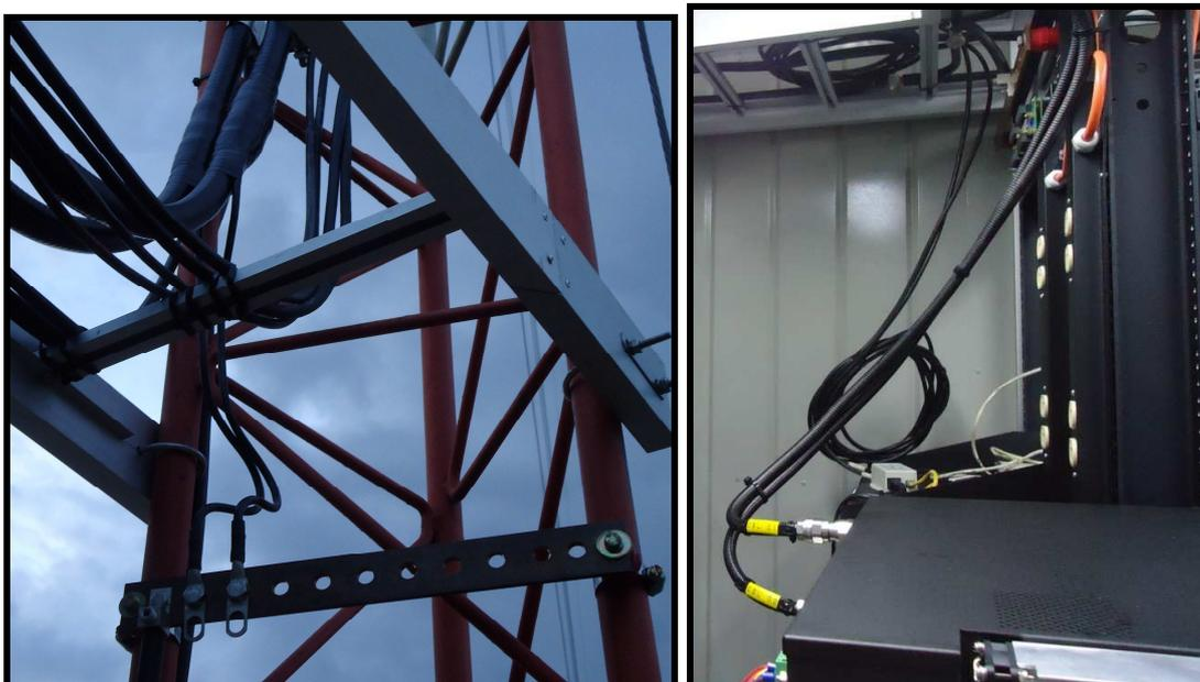
Figura 3.130: Instalación de ground kit y cable superflex en 24 de Mayo.
