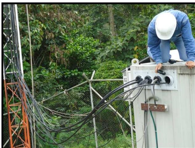
**Figura 3.98: Instalación de los tres cables Heliax de ½".**
