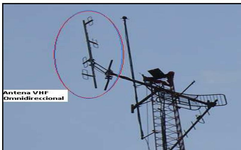
**Figura 1.51: Antena Omnidireccional de 4 dipolos VHF**
