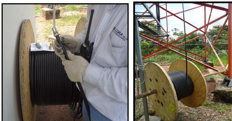
Figura 3.53: Instalación del cable HELIAX y sus conectores.
