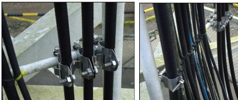
Figura 3.54 Instalación de Hangers kit.
