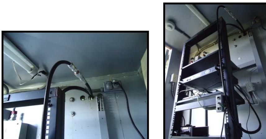
Figura 3.108: Conexión del cable superflex.
