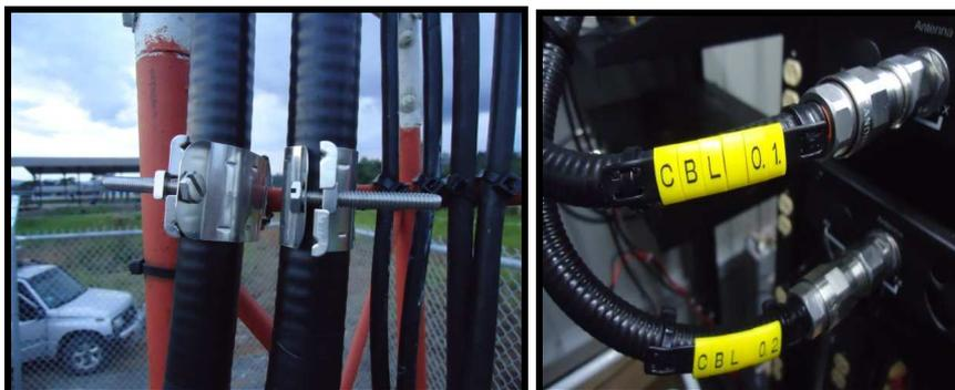
Figura 3.129: Instalación del cable Heliax, hanger kit y etiquetas en 24 de Mayo.
