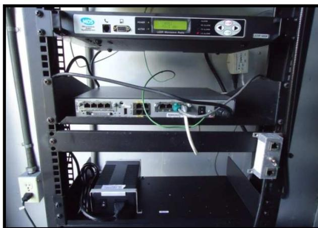
Figura 3.107: Radios MDS y fuentes instalados en el rack de Oso 9.
