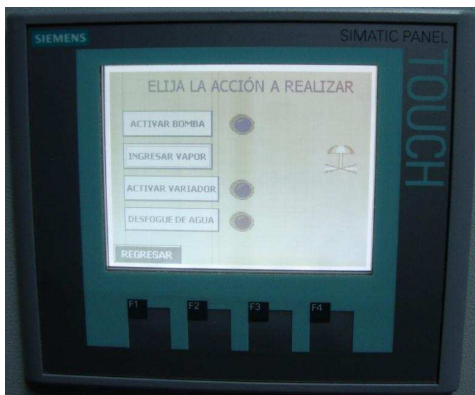
Figura 4.4. Válvula de vapor activada.
