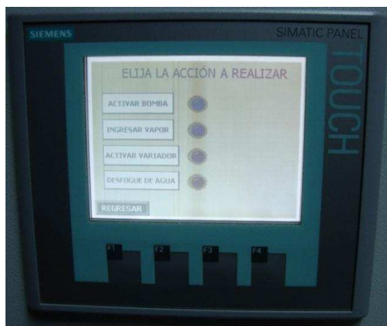
Figura 4.17 Trabajo manual del variador de frecuencia.
