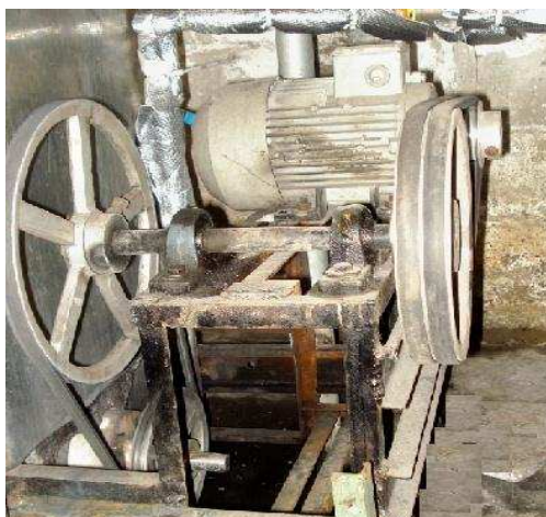
.Figura 2.15.Instalación del motor trifásico
