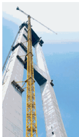
Figura 1.3 Grúa torre trepadora.
