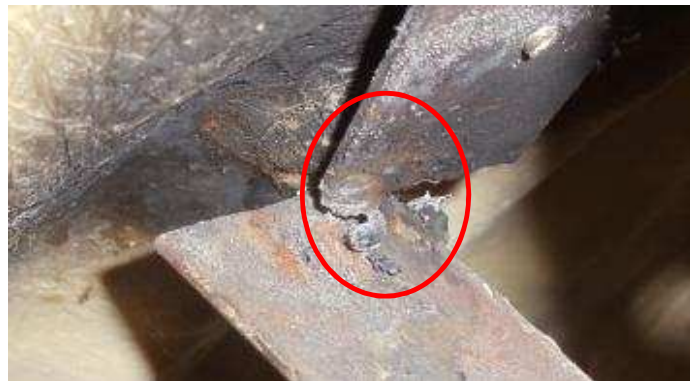
Figura 1.6 Soldadura entre carcasa y estructura
