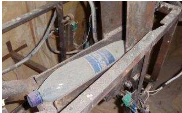
Figura 1.7 Contrapeso de la estructura previa
