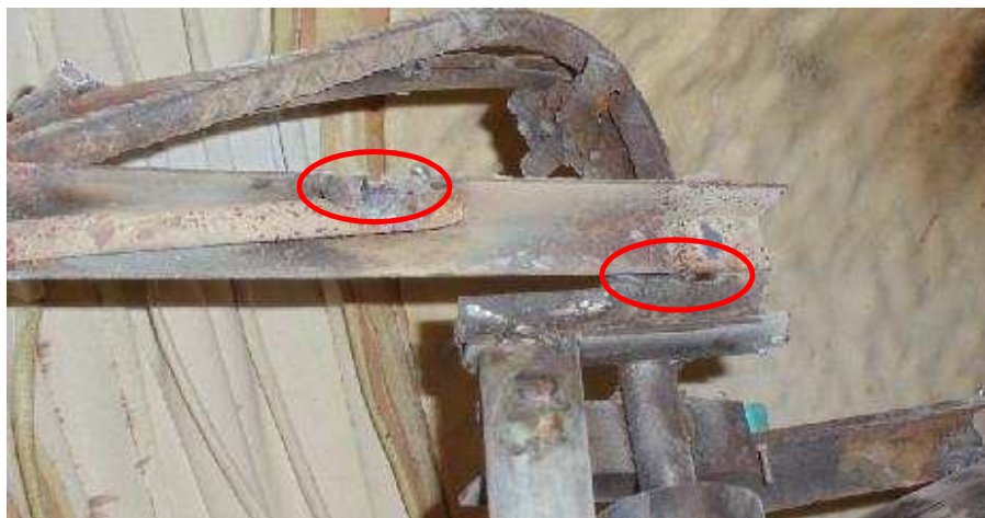
Figura 1.4 Soldadura estructura cuello
