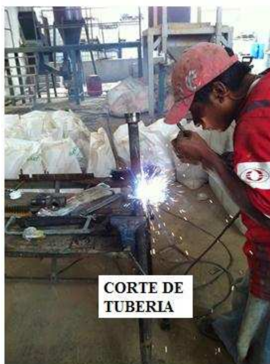
Figura 3. 58 – Corte de tramos de tubería.
