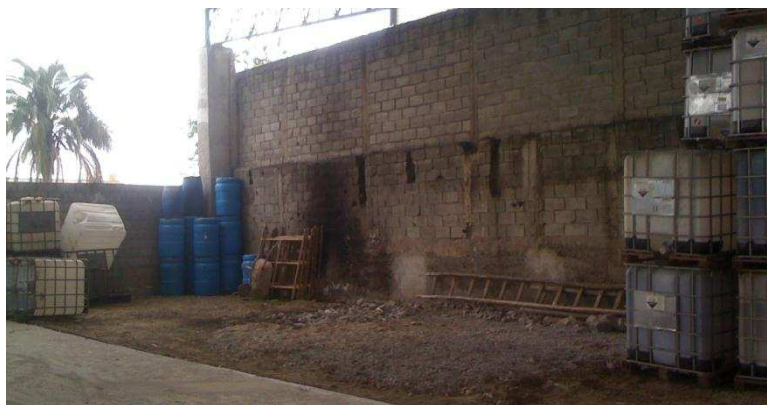
Figura 3. 2 – Sitio destinado para la construcción del sistema.
