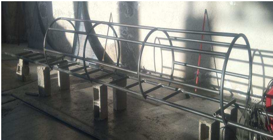
Figura 3. 46 – Construcción de escalera.
