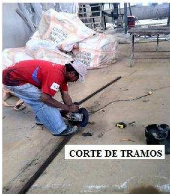
Figura 3. 57 – Corte de tramos de tubería.
