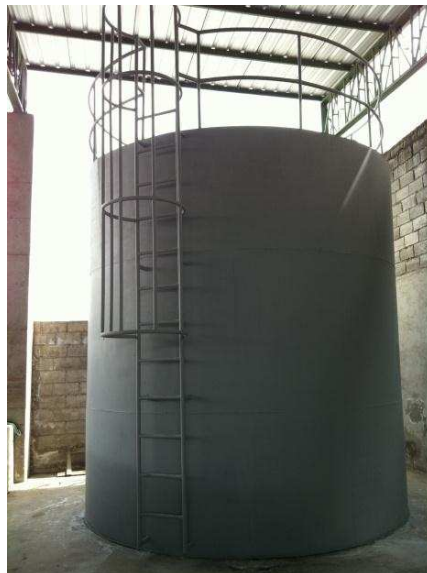
Figura 3. 49 – Fachada del tanque.
