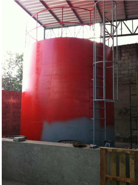
Figura 3. 51 – Capa de pintura exterior del tanque.
