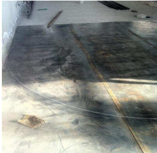
Figura 3. 13 – Construcción de estructura del fondo.
