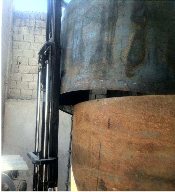
Figura 3. 28 – Ubicación del segundo anillo.
