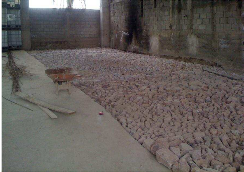
Figura 3. 4 – Capa de piedra por encima de suelo.
