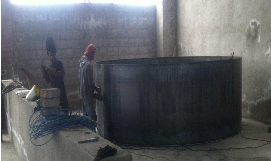
Figura 3. 23 – Construcción del primer anillo.
