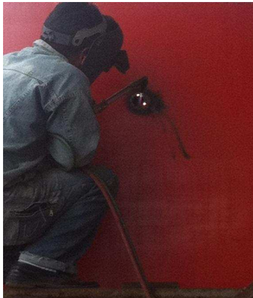
Figura 3. 34 – Proceso de fabricación de boquillas.
