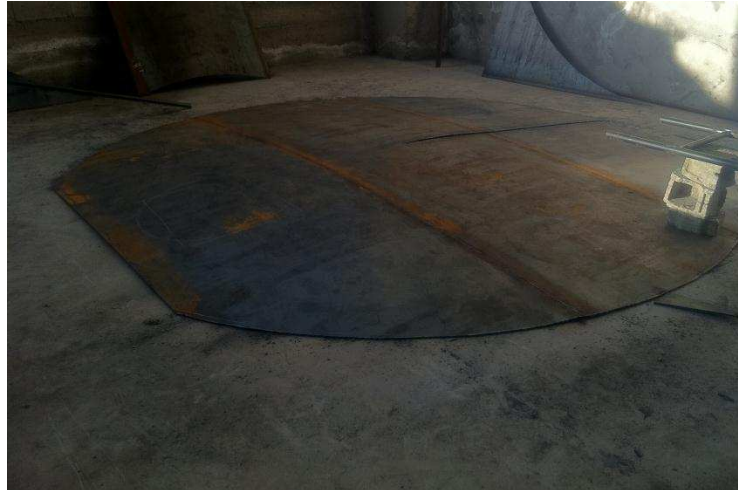
Figura 3. 19 – Estructura del techo terminado.
