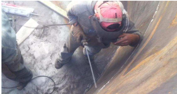
Figura 3. 30 – Montaje de segundo anillo.
