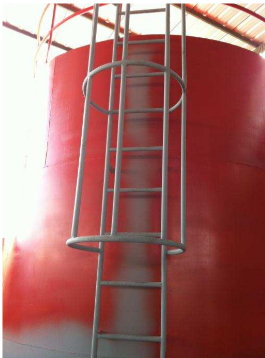
Figura 3. 50 – Capa de pintura exterior del tanque.
