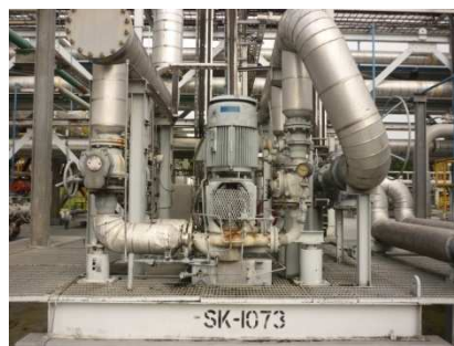
Figura 3.227: Bombas del deshidratador electrostático P-2073 A/B
