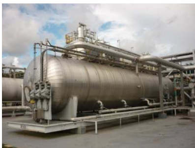
Figura 3.226: Deshidratador electrostático
