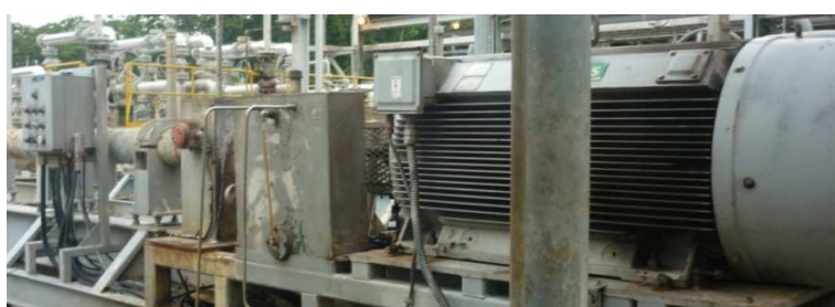
Figura 3.137: Bomba de alta presión
