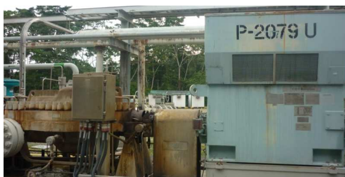
Figura 3.100: Bomba de alta presión
