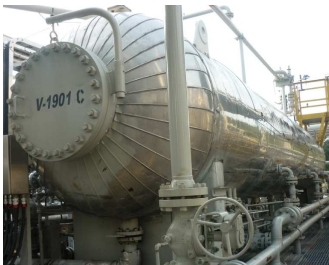
Figura 3.162: Separador de prueba
