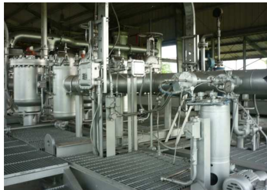
Figura 3.281: Sistema de medición SOTE
