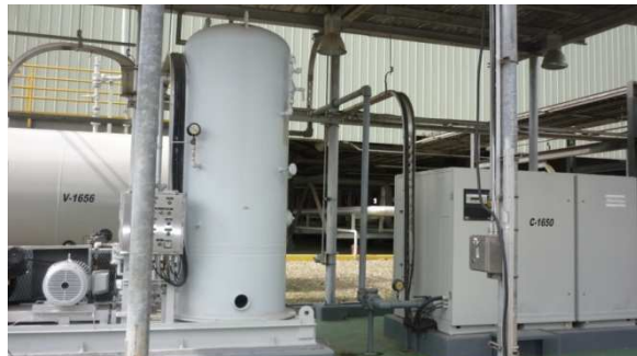
Figura 3.270: Sistema de aire de instrumentos
