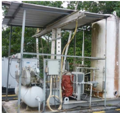
Figura 3.36: Compresores de aire tipo pistón
