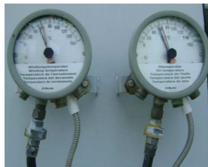
Figura 2.52: Medidores de temperatura del aceite y devanado
