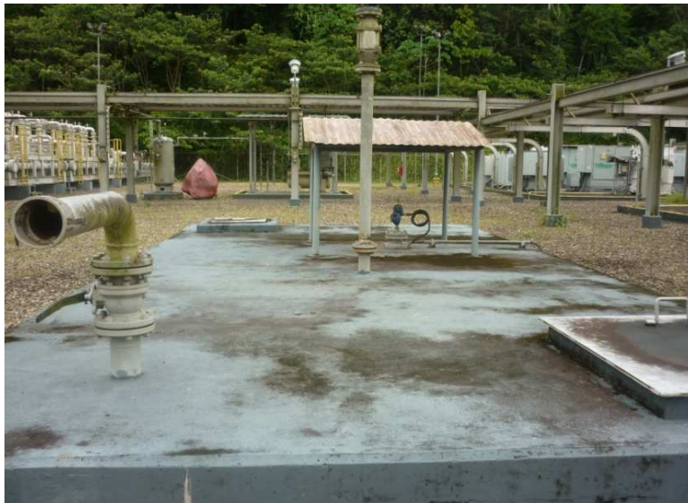
Figura 3.23: Tanque slop
