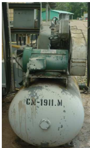
Figura 3.36: Compresores de aire tipo pistón
