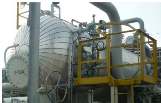
Figura 3.169: Tanque de Surgencia
