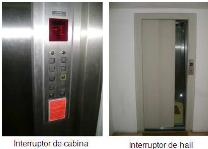
Figura 3.22 – Contactos normalmente abiertos de cabina y hall.
