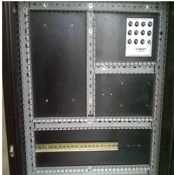
Figura 2.16 - Colocación de las canaletas, soportes de PLC, caja de fusibles.
