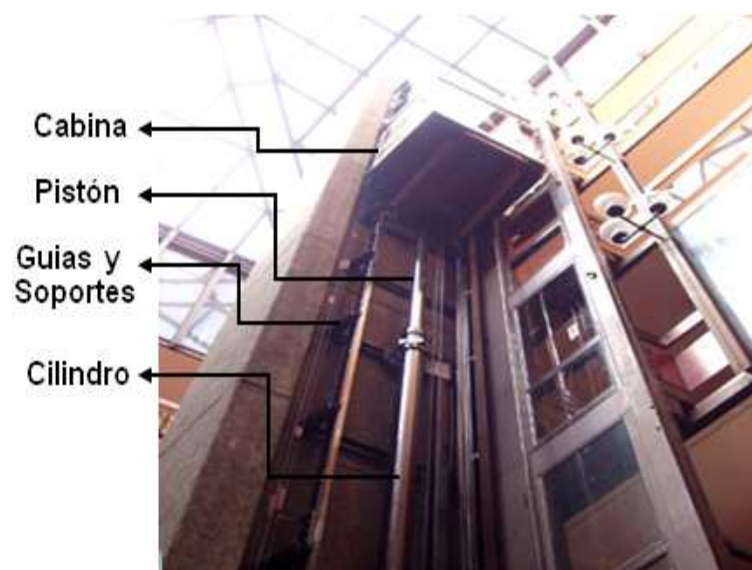
Figura 1.5 - Ascensor con sistema hidráulico lateral.
