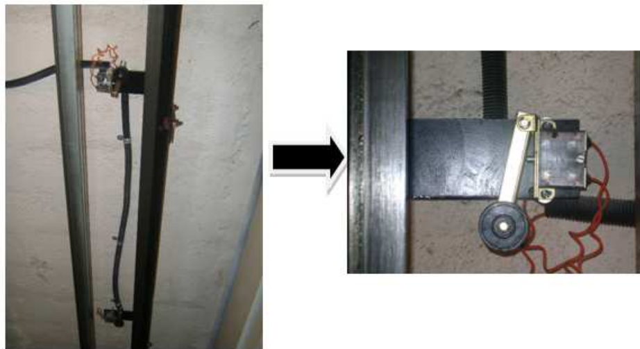
Figura 3.19 – Micros interruptores fin de carrera.
