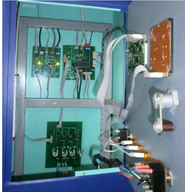
Figura 4. 12 Vista interna del Panel de Supervisión del Tensiómetro
