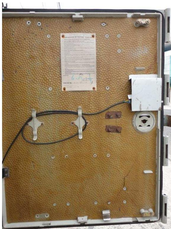
**Figura 4.7:** Instalación de la cerradura eléctrica
