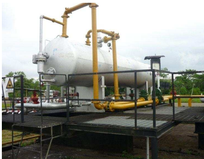
FOTO 1.6 SEPARADOR DE PRUEBA
