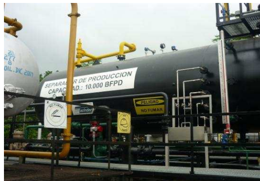
FOTO 1.23 SEPARADOR DE PRODUCCIÓN
