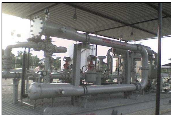
FIGURA A.9.22 UNIDAD DE MEDICIÓN – ESTACIÓN ATACAPI
