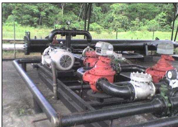
FIGURA A.9.20 UNIDAD DE MEDICIÓN – ESTACIÓN SHUARA
