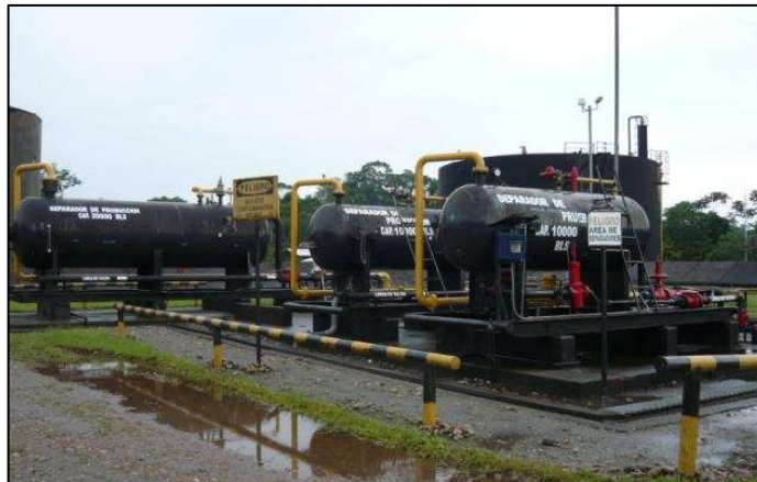
FIGURA A.9.14 SEPARADORES – ESTACIÓN TETETE
