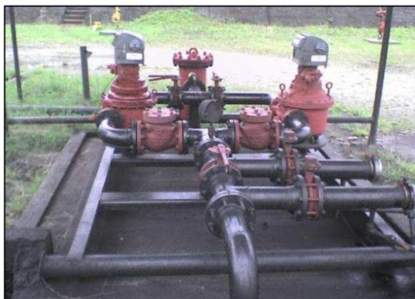
FIGURA A.9.19 UNIDADES DE MEDICIÓN – ESTACIÓN SHUSHUQUI
