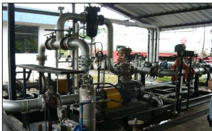
FIGURA A.9.17 UNIDADES DE MEDICIÓN – ESTACIÓN TETETE
