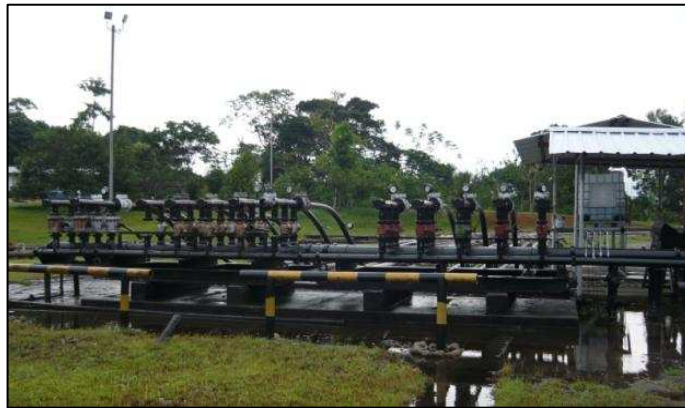
FIGURA A.9.13 MANIFOLD – ESTACIÓN TETETE
