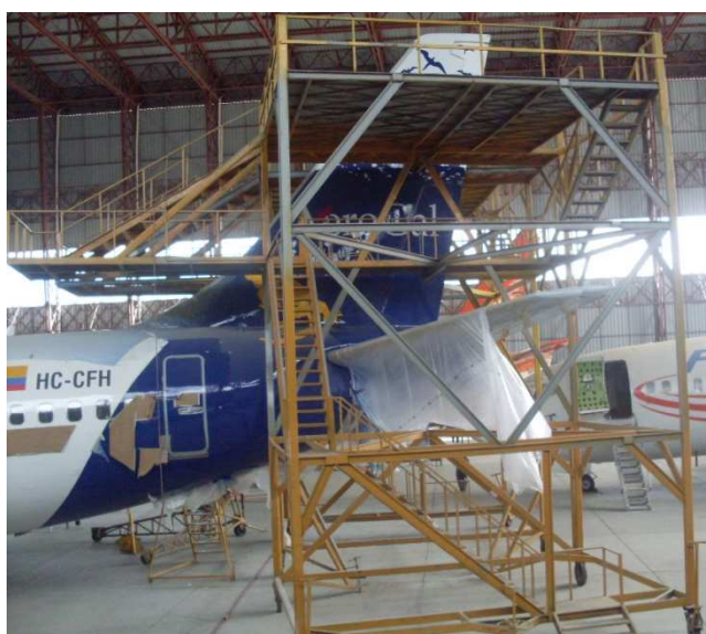
Fig. 1.1 Estructura de trabajo utilizada en el CEMA
