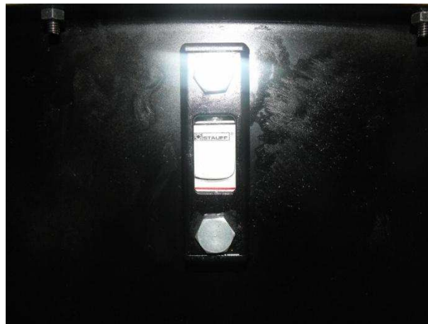
Figura 6-13: Mirilla del tanque reservorio
