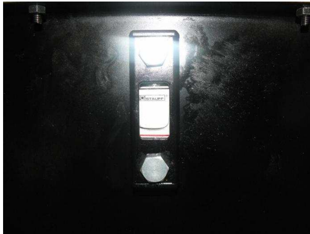
Figura 6-2: Mirilla del tanque reservorio
