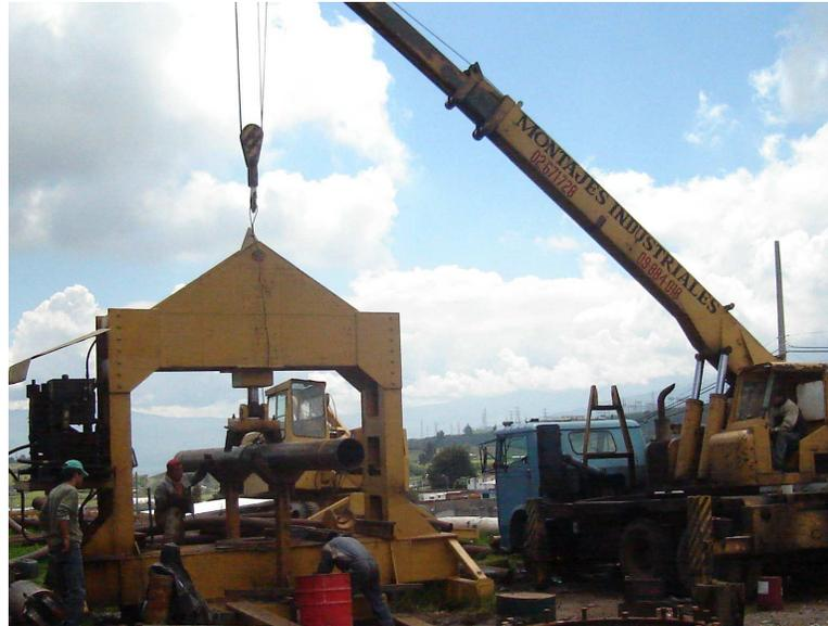
**FOTOGRAFÍA No 8:** Montaje de tubería sobre soportes
