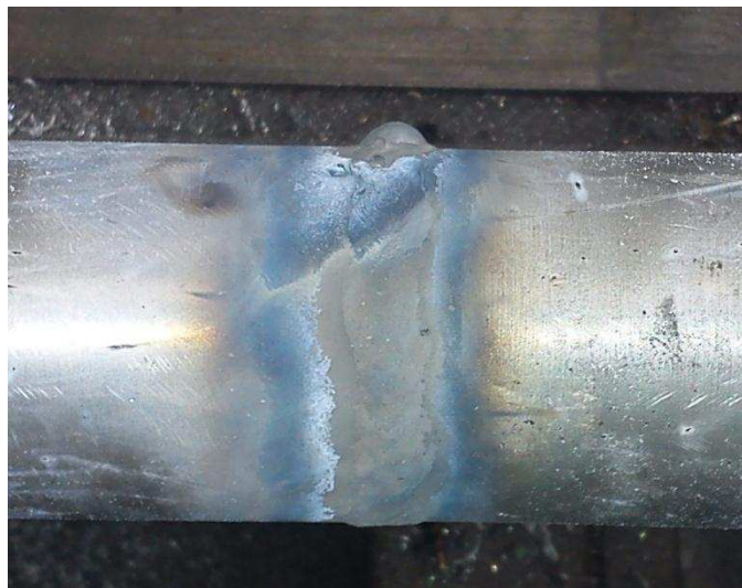
Imagen 29. Cordón de soldadura TIG, se puede distinguir la zona afectada por el calor.
