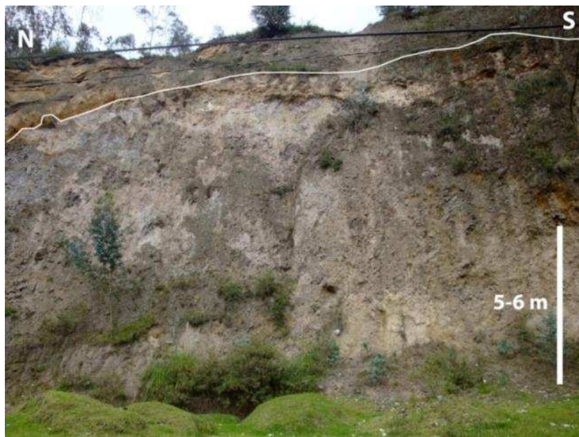
Figura 4.46. Entrada a la comunidad San Luis en la vía a Guaranda, cerca de Juan Benigno Vela.
