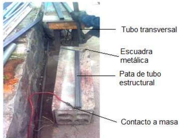
Figura 3.1 Unión de tubos estructurales metálicos.
