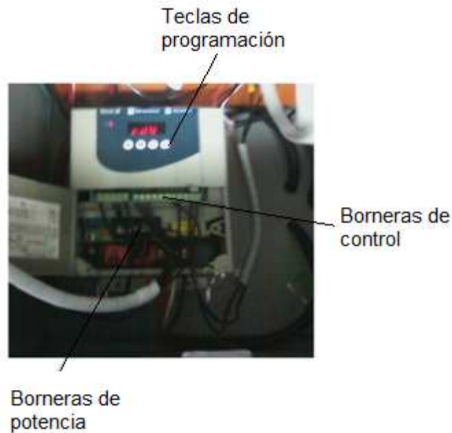
Figura 3.24 Variador Altivar 28 telemecanique.
