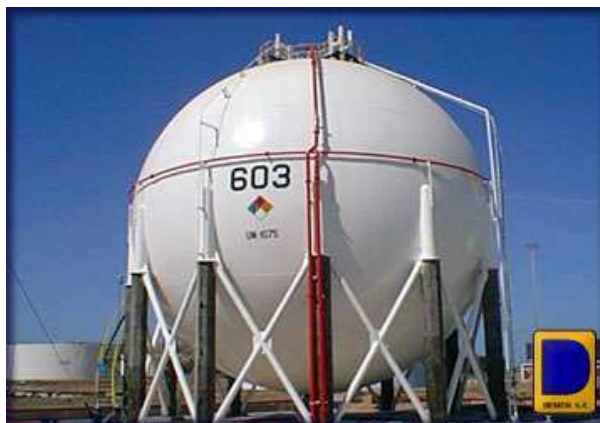
Figura 2.5. Tanque de almacenamiento Esférico. 5
