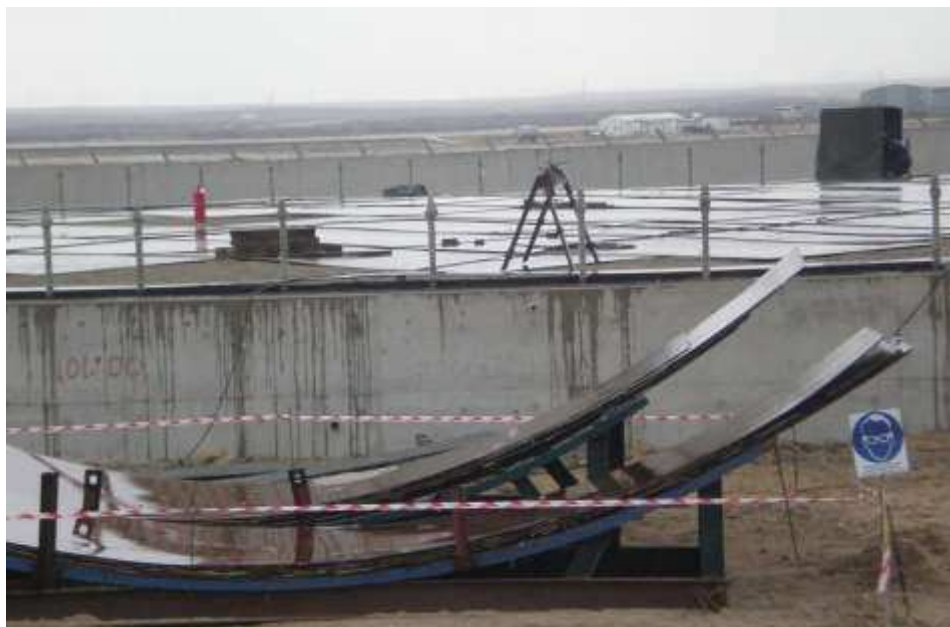
Figura. 5.1 Cimentación tanque de almacenamiento.
