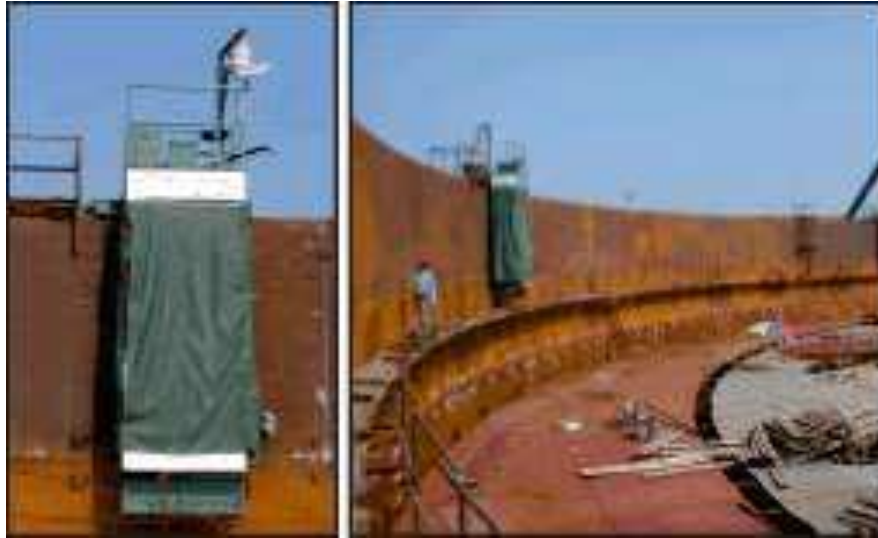
Figura. 5. 7 Uso de Buggys en el montaje de tanques.
