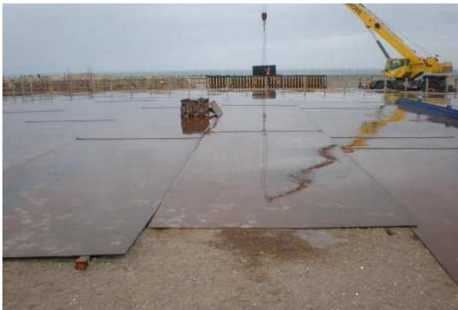
Figura. 5. 2 Distribución planchas de fondo.
