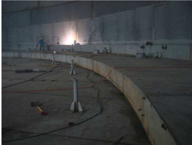
Figura. 5. 10 Pontones armados.
