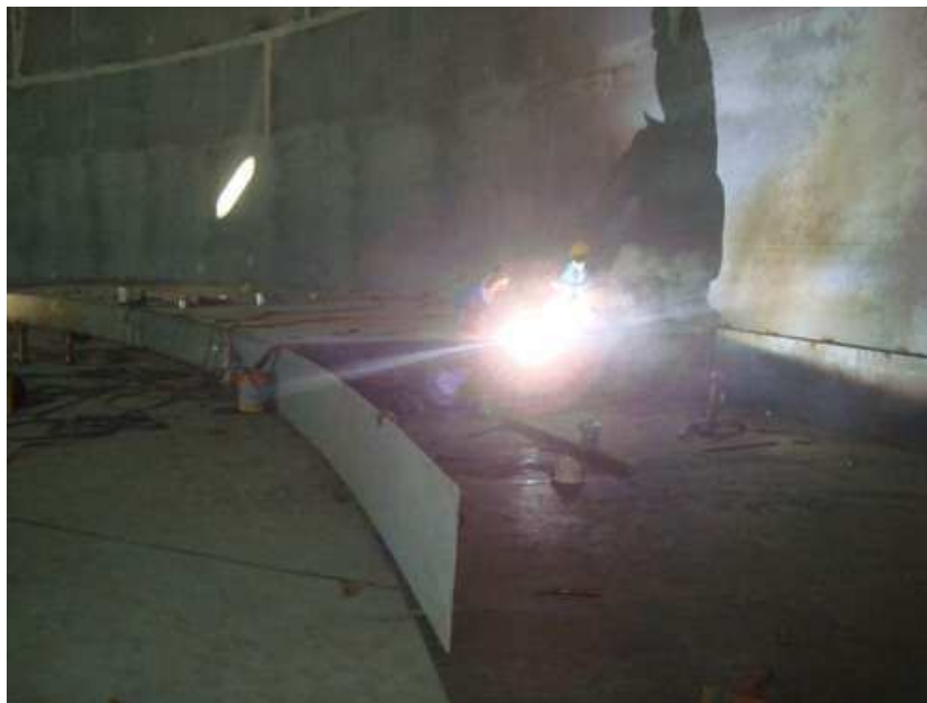
Figura. 5. 9 Soldadura pontones.
