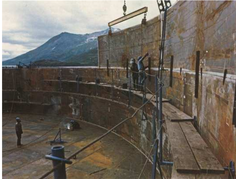
Figura. 5. 4 Detalle montaje cuerpo dentro del tanque.
