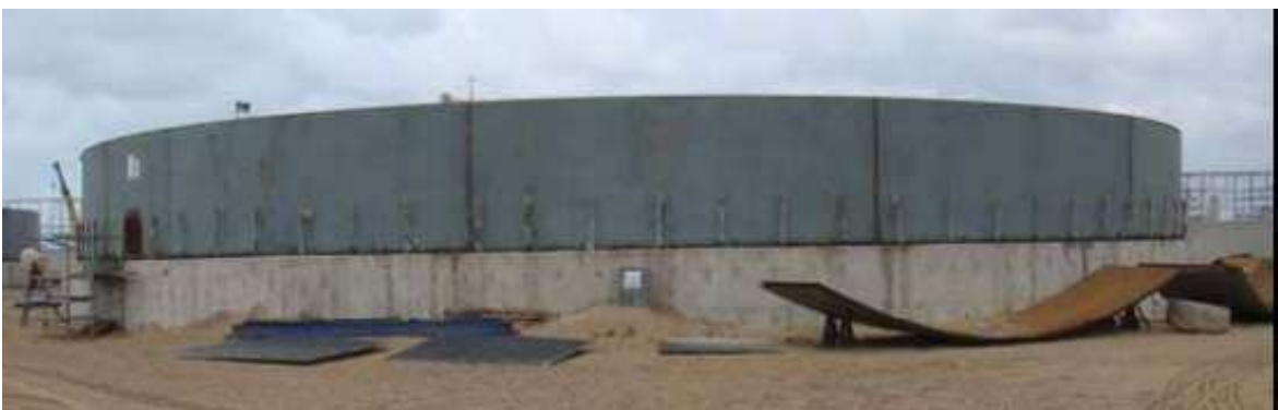
Figura. 5. 6 Montaje primer anillo.
