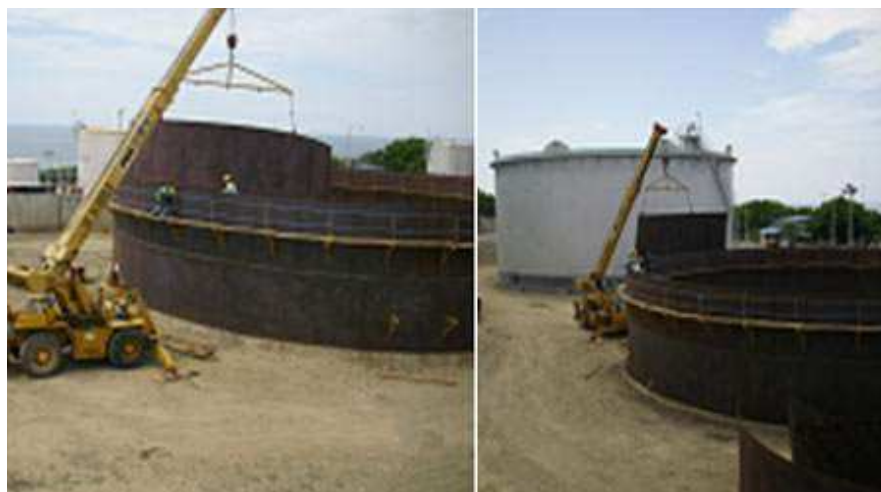
Figura. 5. 8 Montaje anillos tanque.
