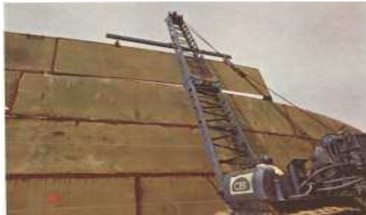
Figura. 5. 5 Montaje de planchas usando grúa
