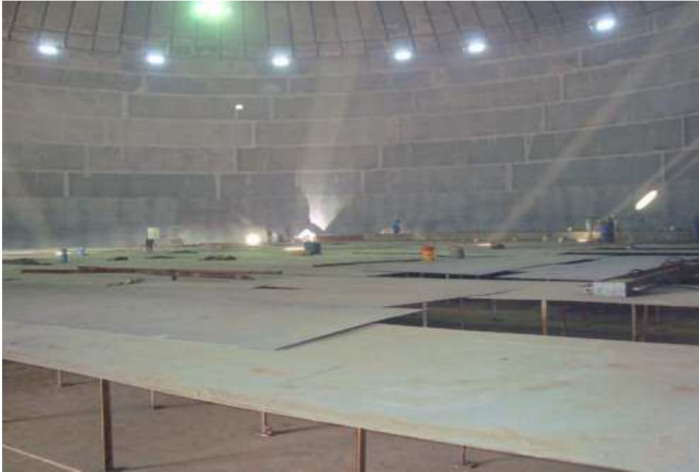
Figura. 5. 11 Obra falsa montaje deck.
