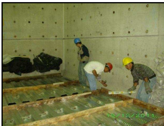
FOTO 3.10. ENCOFRADO DE LAS LOSAS
