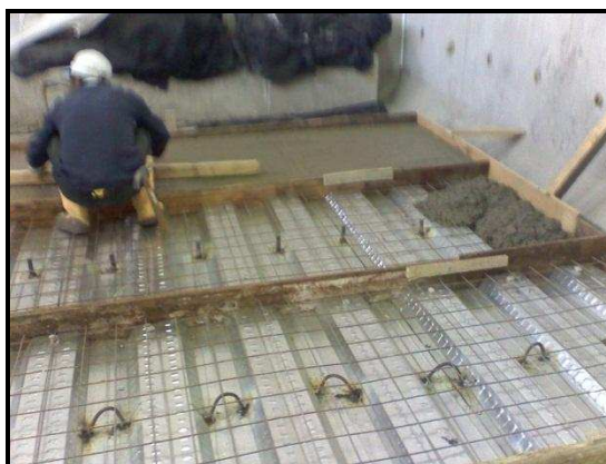
FOTO 3.15. ENLUCIDO DEL HORMIGÓN
