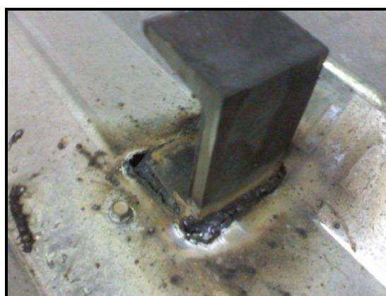
FOTO 3.8. CONECTORES DE CORTE CON SECCIONES UPN
