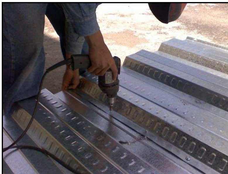
FOTO 3.2. COLOCACIÓN DE PERNOS PARA ASEGURAR EL TRASLAPE DE LAS PLANCHAS.
