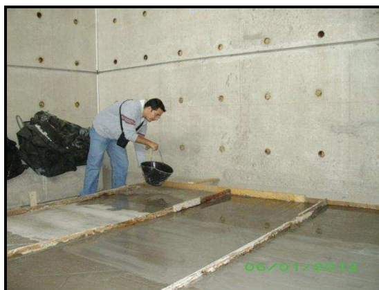
FOTO 3.16. CURADO DEL HORMIGÓN
