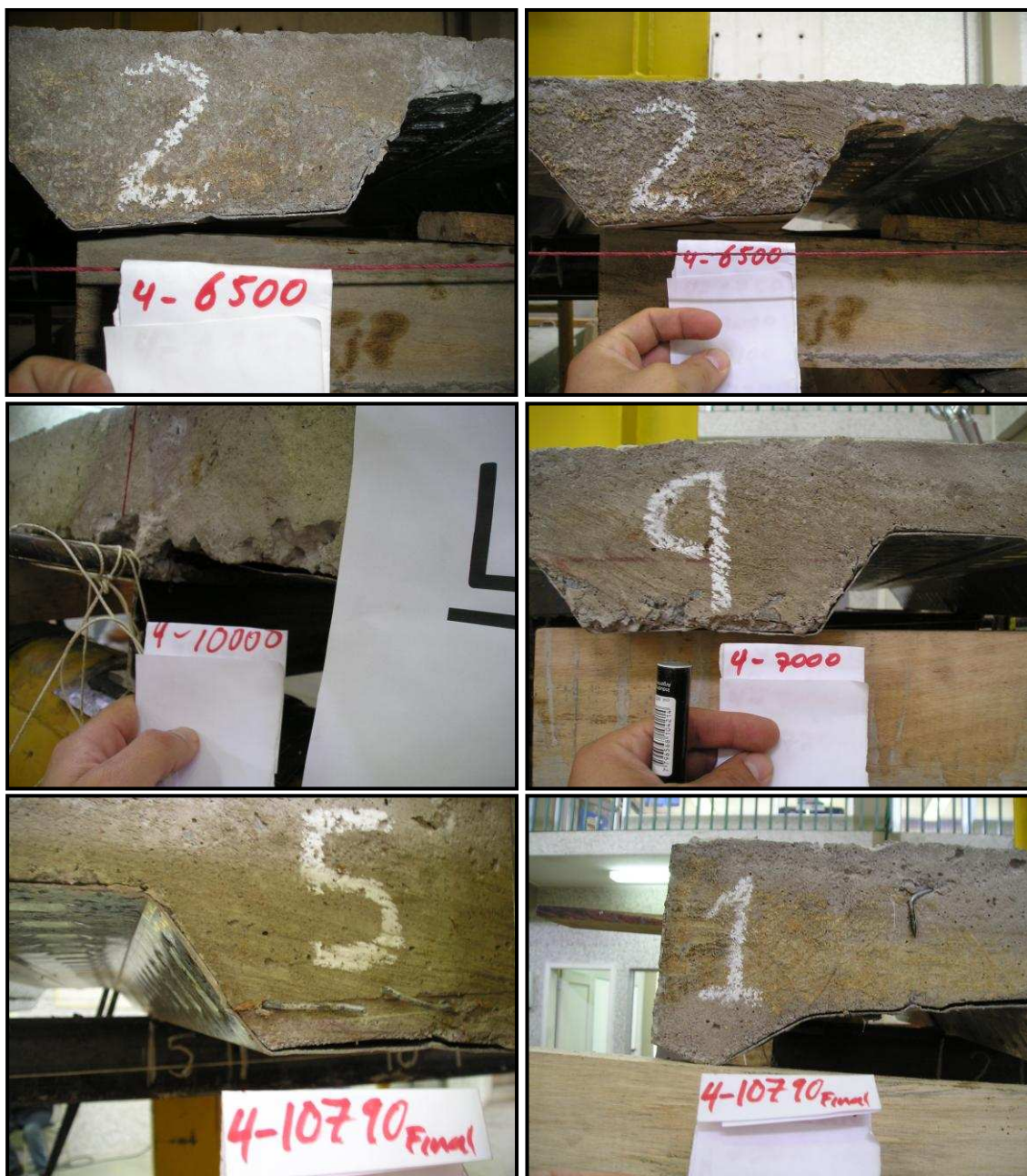
FOTO 4.13. DESPRENDIMIENTO DE LA PLACA COLABORANTE DURANTE TODO EL PROCESO DE APLICACIÓN DE CICLOS DE CARGA
