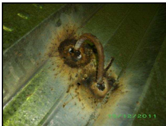
FOTO 3.7. CONECTORES DE CORTE EN FORMA DE ARCO CON VARILLA DE 10MM
