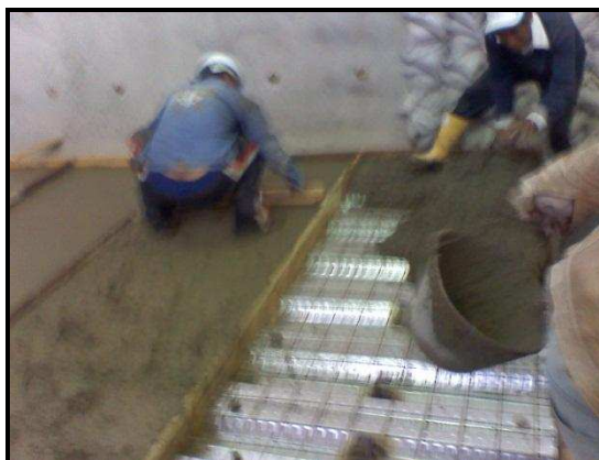
FOTO 3.14. VERTIDO DE HORMIGÓN
