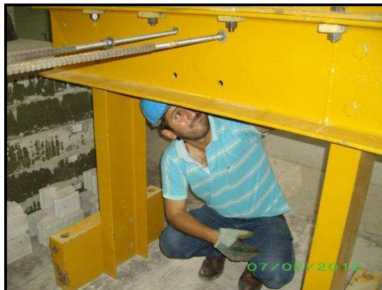
FOTO 3.22. INSTALACIÓN DE LOS APOYOS.
