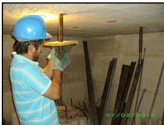
FOTO 3.23. AJUSTE DE LOS ANCLAJES DE LOS APOYOS.
