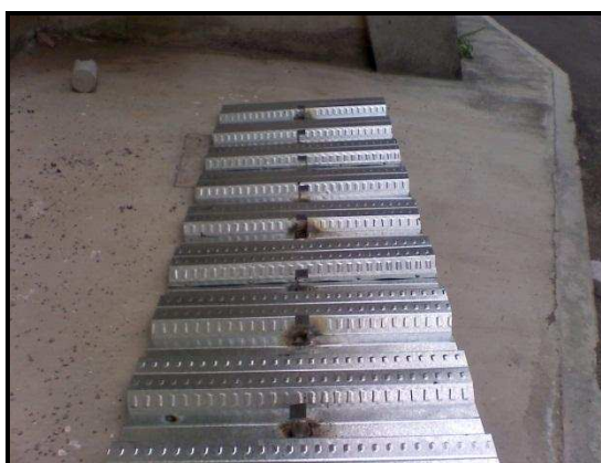
FOTO 3.5. CONECTORES DE CORTE UPN COLOCADOS CAMBIANDO DIRECCIÓN EN CADA VALLE
