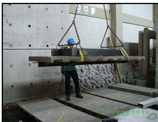
FOTO 3.21. IZAJE DE LAS LOSAS
