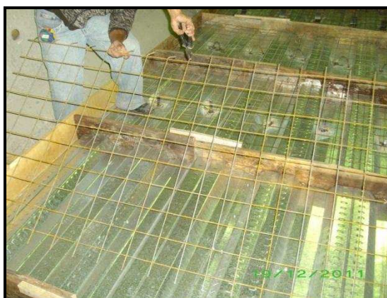
FOTO 3.13. COLOCACIÓN DE LA MALLA ELECTROSOLDADA
