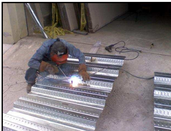
FOTO 3.3. SOLDADA DE LOS CONECTORES DE CORTE
