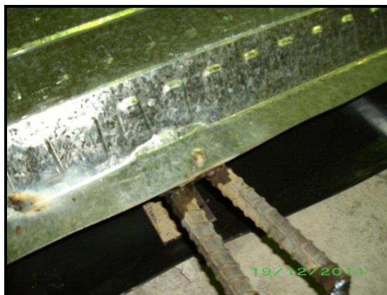
FOTO 3.9. VARILLAS SOLDADAS A LA VIGA I PARA MEJOR MANIPULACIÓN E IZAJE DE LAS LOSAS DECK
