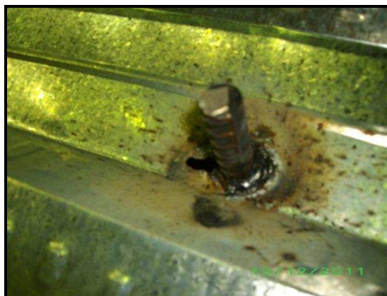
FOTO 3.6. CONECTORES DE CORTE CON VARILLA DE 16MM
