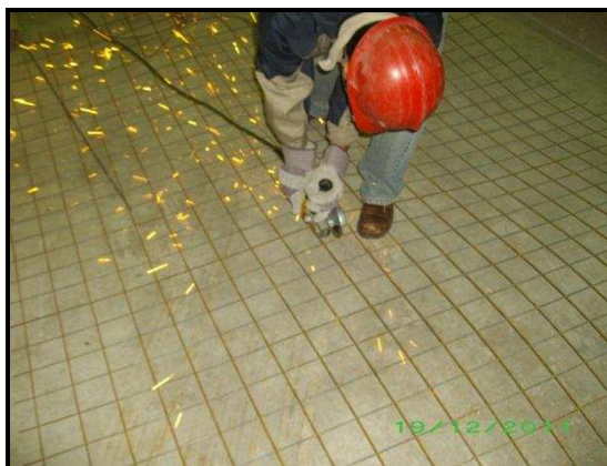
FOTO 3.12. CORTADO DE LA MALLA ELECTROSOLDADA
