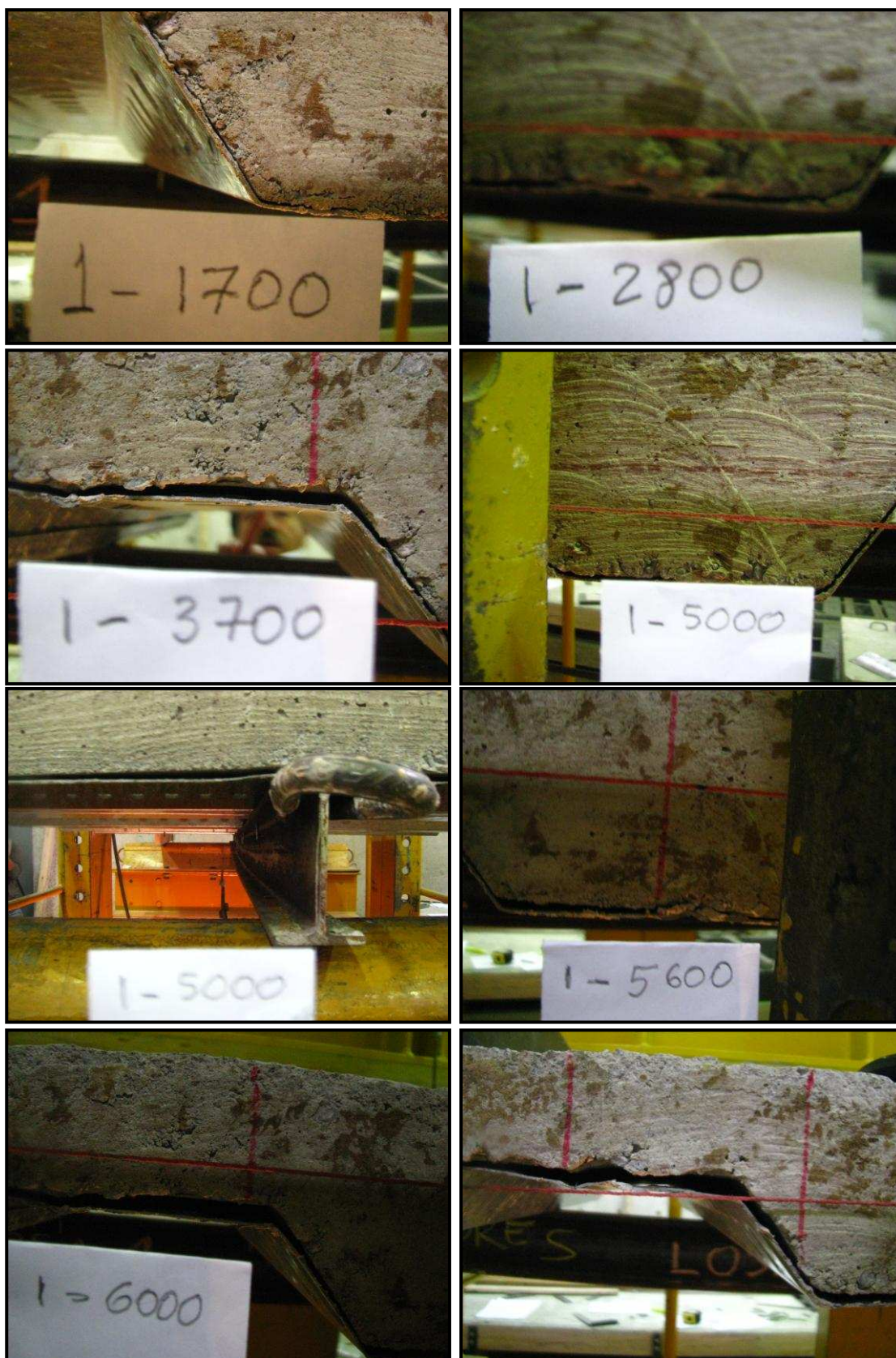
FOTO 4.1. PÉRDIDA DE ADHERENCIA ENTRE EL DECK Y EL HORMIGÓN
