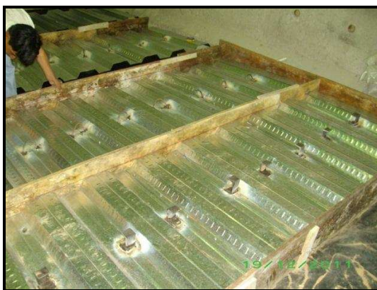
FOTO 3.11. TIMBRADO DEL NIVEL MÁXIMO DE FUNDICIÓN
