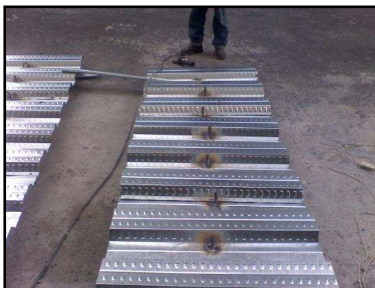
FOTO 3.4. CONECTORES DE CORTE COLOCADOS DE MANERA ZIGZAGUEANTE SOBRE EL EJE LONGITUDINAL
