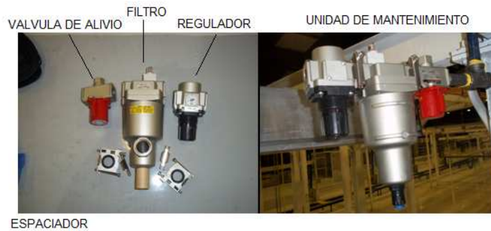
Figura 4.26 Instalación de la unidad de mantenimiento
