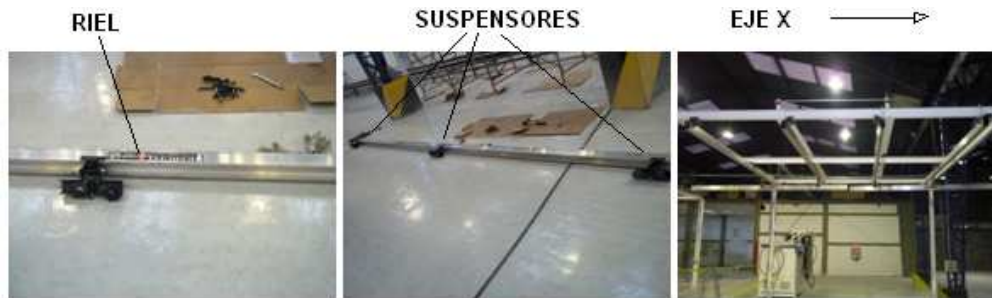
Figura 4.4 Montaje de rieles.
