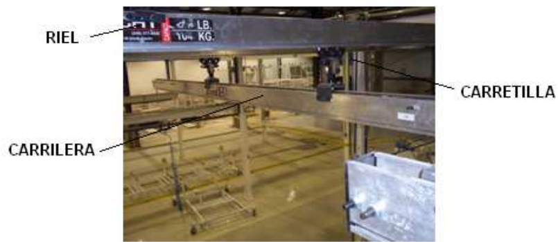
Figura 4.8 Montaje de una carrilera.
