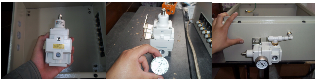
Figura 4.23 Montaje de equipos en el gabinete
