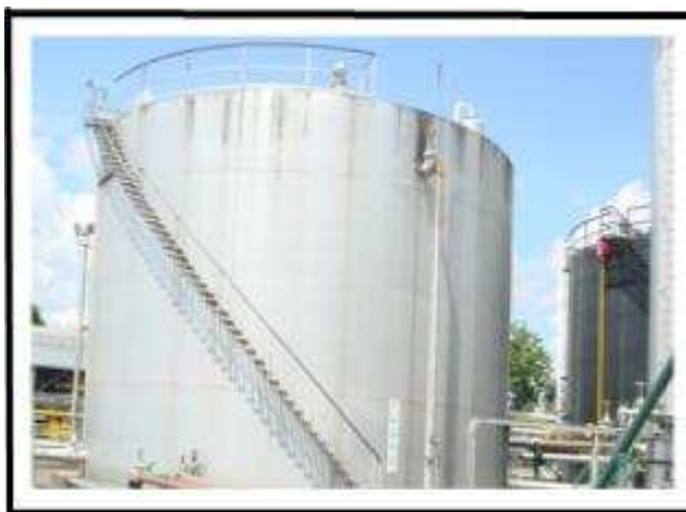
Figura 2.4 Tanques de lavado y almacenamiento de crudo
