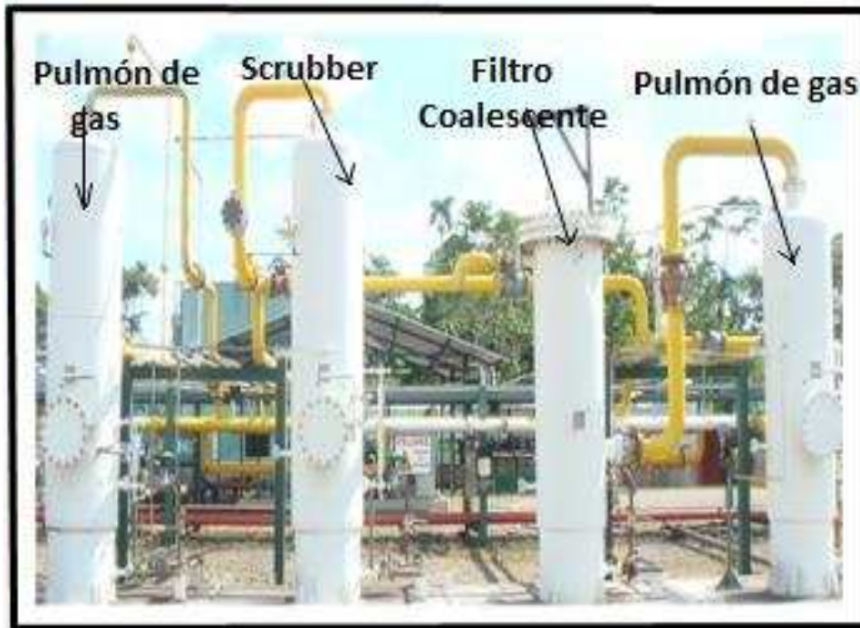
Figura 2.5 Sección de tratamiento del gas
