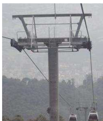
Figura 1.12 Torres del sistema teleférico.
