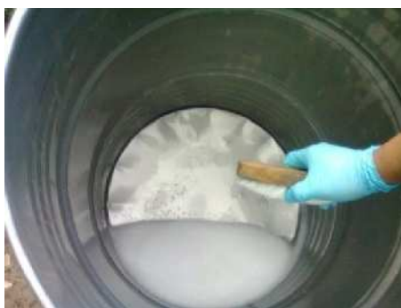
Figura 3.21- Aplicación del antioxidante al tanque.
