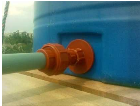
Figura 3.42- Seccionamiento mediante universales.
