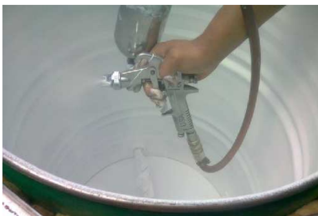
Figura 3.23- Aplicación de la pintura al tanque.
