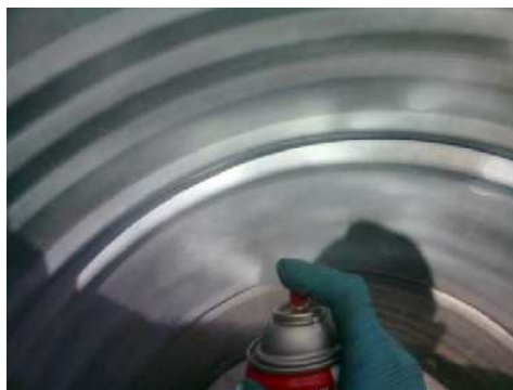
Figura 3.22- Aplicación del fondo al tanque.
