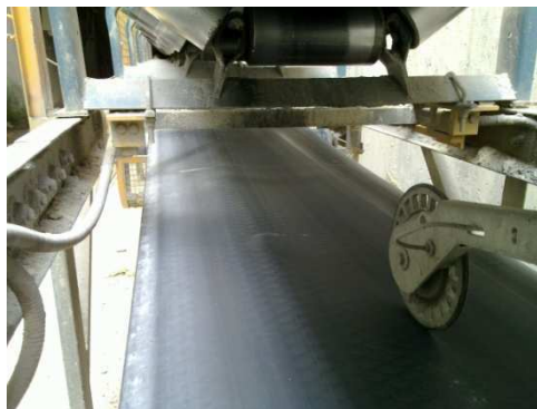
Figura 4.42 Instalación de la Báscula en la Primera Cinta Transportadora
