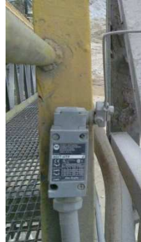
Figura 4.29 Fin de Carrera Alto del Elevador
