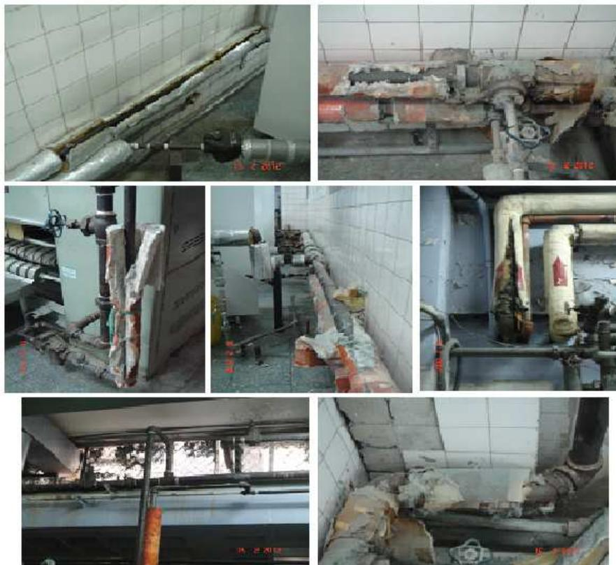
**Fotografía 2. 17** Fotografías de las tuberías sin aislamiento.
