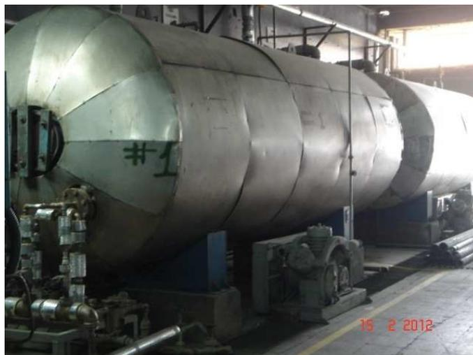
**Fotografía 2.4** Tanques de almacenamiento de agua de alimentación [Fuente: propia].
