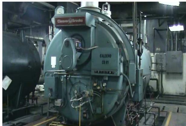
**Fotografía 2. 1** Caldera pirotubular Cleaver Brooks [Fuente: propia].
