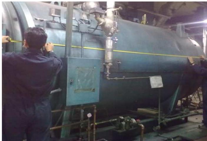
Fotografía 2. 15 Medición de temperatura superficial en la caldera.
