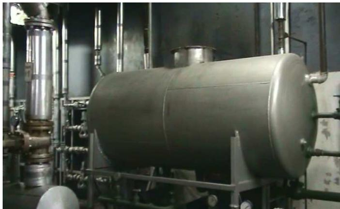
**Fotografía 2. 5** Tanque de condensado N.01 [Fuente: propia].
