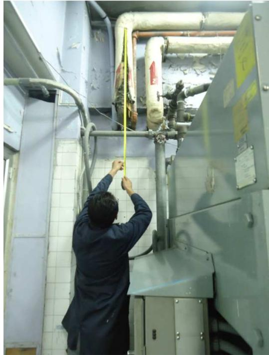
Medición de la longitud de la tubería con aislante dañado
