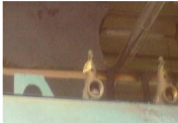
**Fotografía 2. 18** Pérdidas de vapor en la válvula de seguridad de la caldera.
