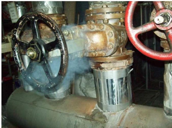
Fotografía 2. 19 Fuga de vapor en la válvula del distribuidor.
