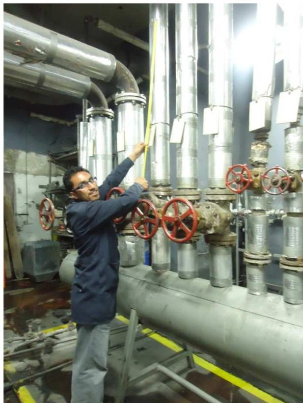
Medición de la longitud de la tubería con aislante del distribuidor
