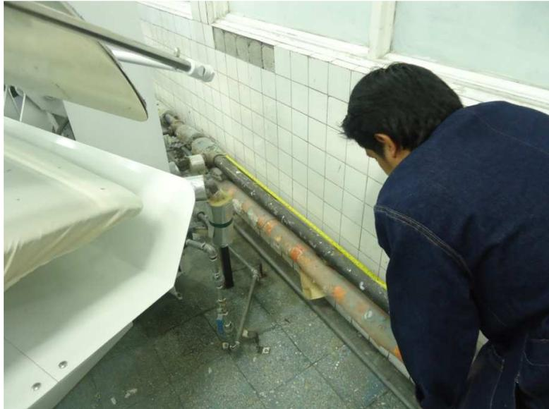
Medición de la longitud de la tubería sin aislante
