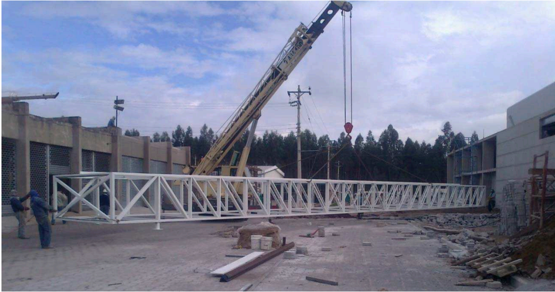
Fig. 4.13: Montaje del Puente: Paso 2 157
