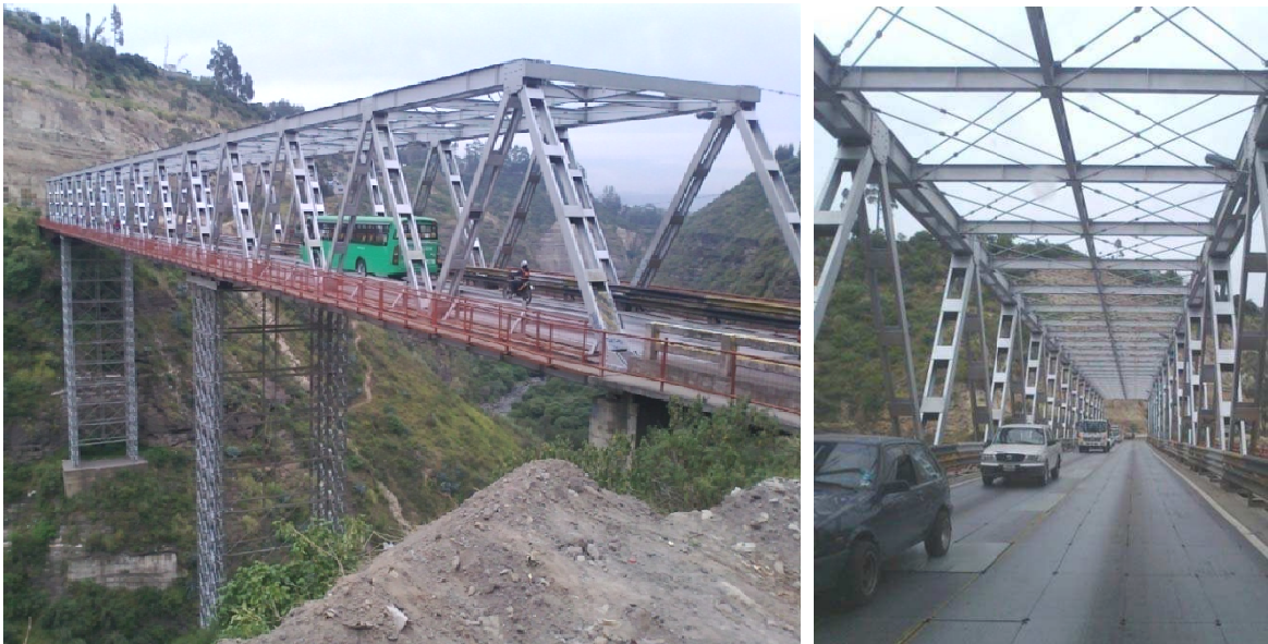
Fig. 1.23: Puente sobre el Río Chiche, Puenbo, Ecuador 23
