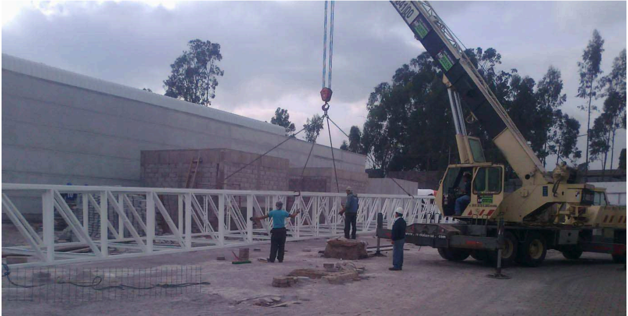
Fig. 4.12: Montaje del Puente: Paso 1 156
