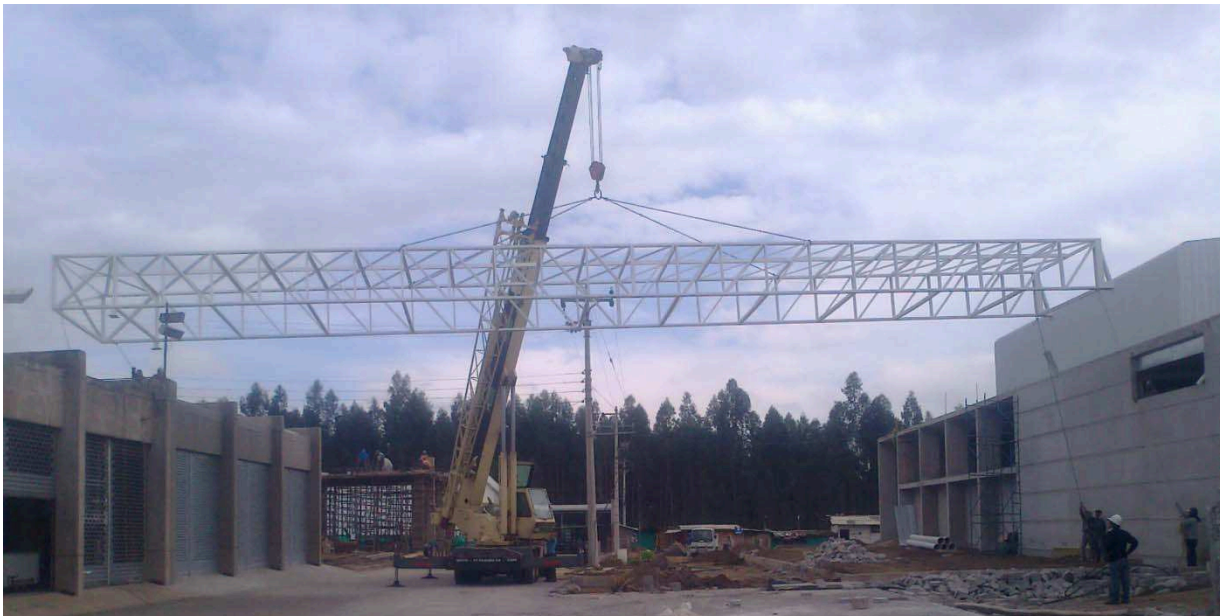
Fig. 4.14: Montaje de Puente: Paso 3 158
