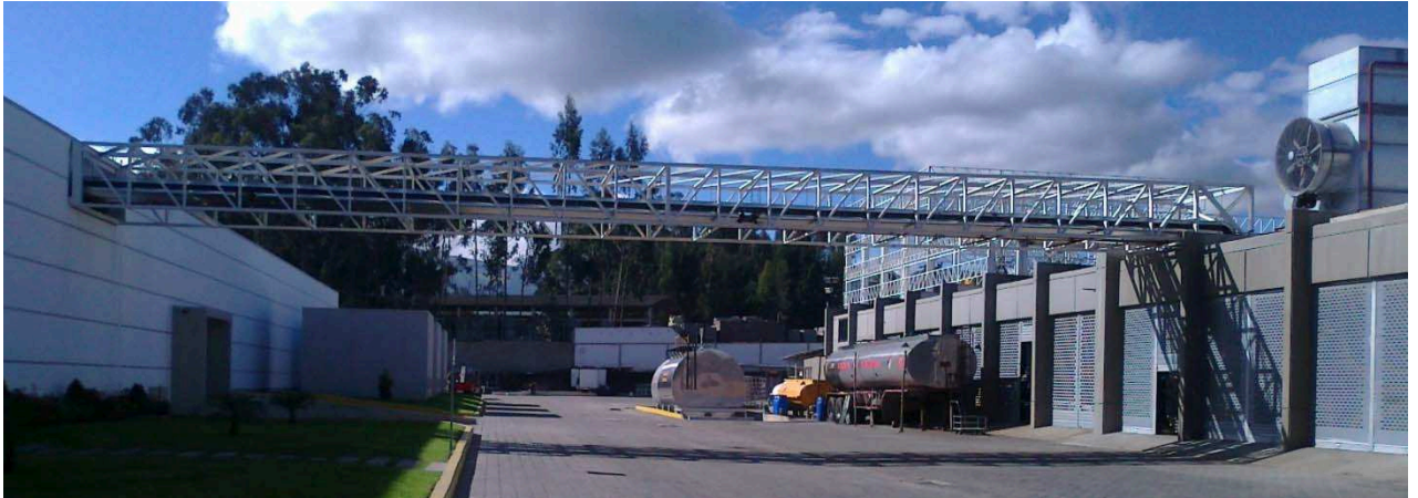
Fig. 4.18: Vista lateral del puente en funcionamiento 162
