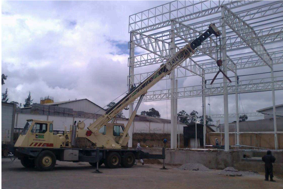
Fig. 4.2: Elevación de partes de una estructura mediante grúa 146
