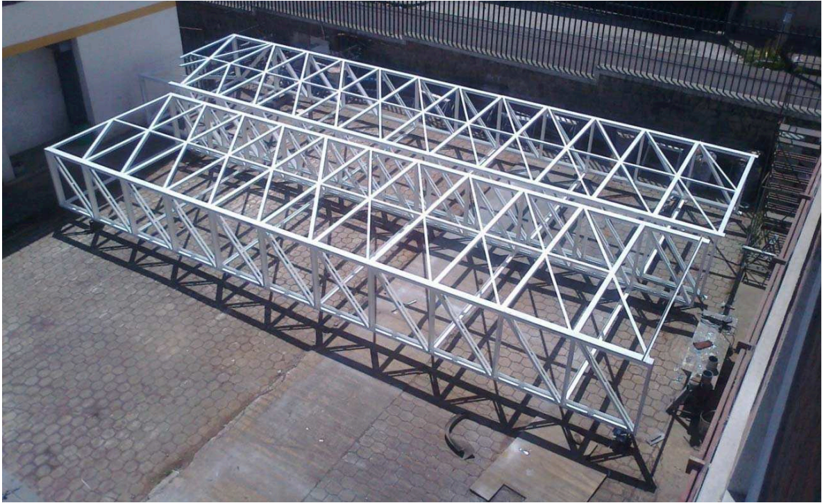
Fig. 4.3: Mitades del Puente colocadas en Taller previo al traslado. 147
