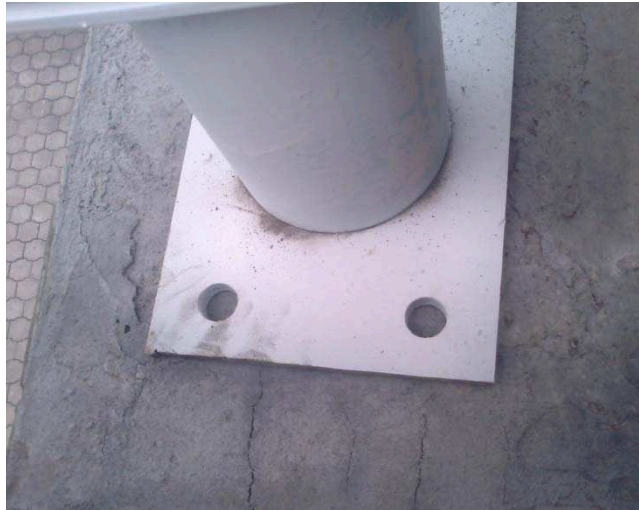
Fig. 4.16: Apoyo en casa de fuerza antes de colocar pernos de anclaje 160
