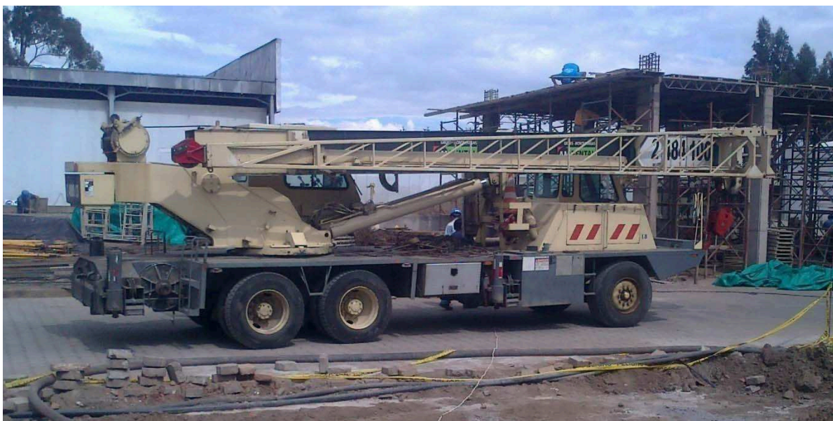
Fig. 4.8: Grúa de 30 Toneladas utilizada en el montaje 152
