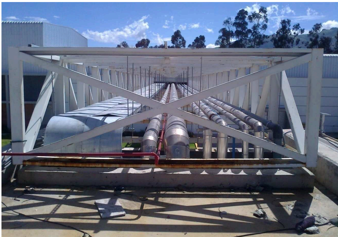
Fig. 4.19: Vista posterior del puente en funcionamiento 163
