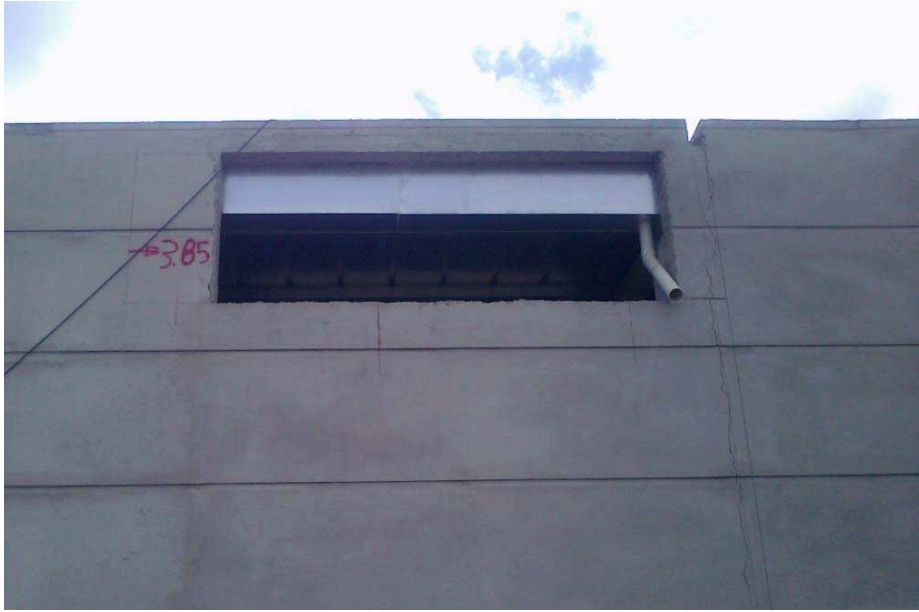
Fig. 4.9: Vista exterior de la pared en la nueva planta 153
