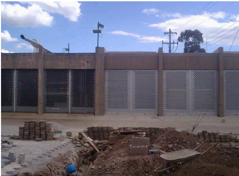
Fig. 4.10: Vista exterior del apoyo en la losa de casa de fuerza 154
