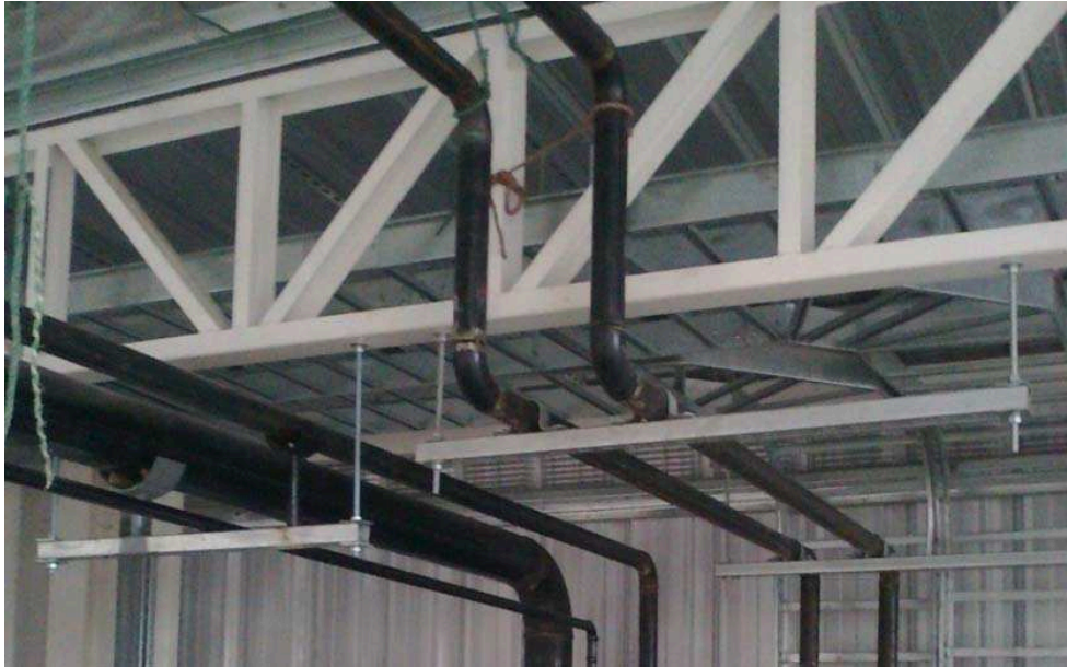
Fig. 3.2: Ejemplo de tuberías instaladas utilizando columpios METALECTRO 43
