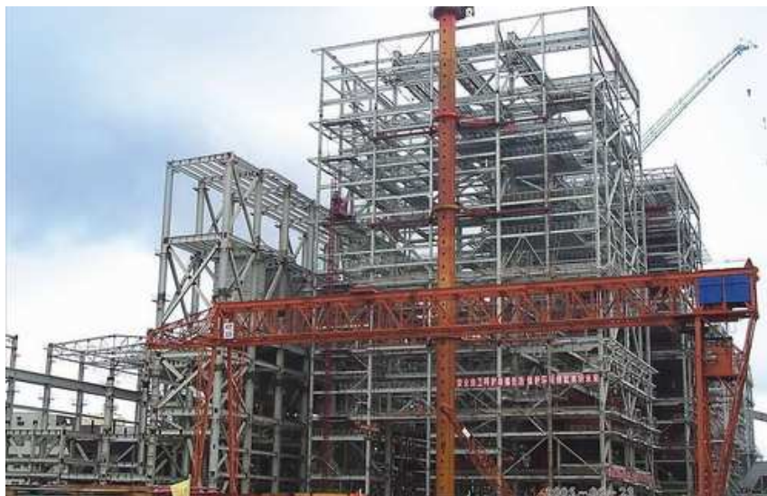
Fig. 1.7: Estructura metálica para planta de generación eléctrica con carbón 7
