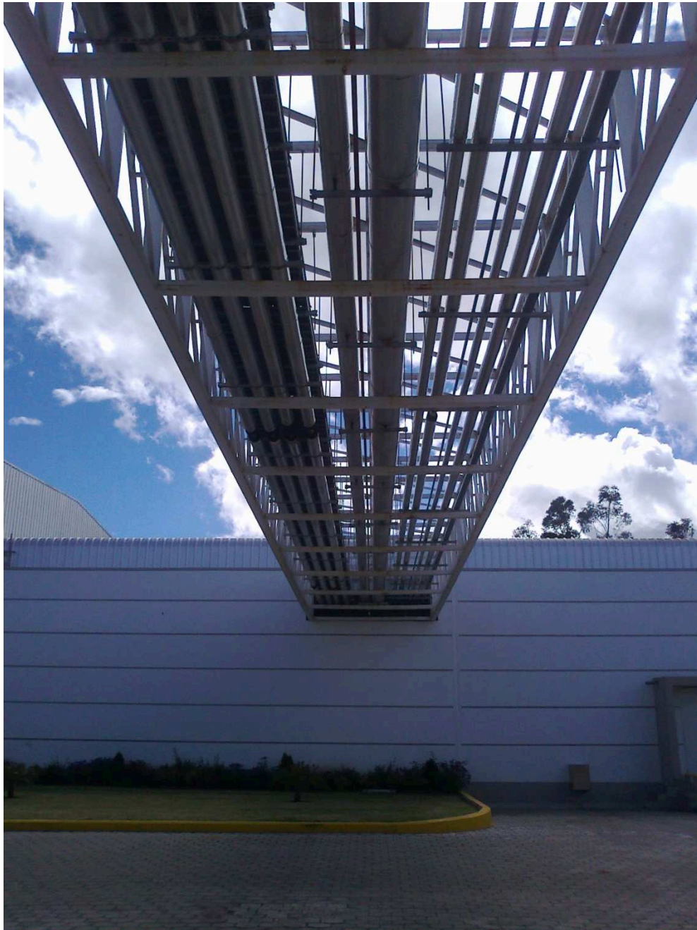
Fig. 4.21: Vista inferior del puente hacia Planta de Preformados 165
