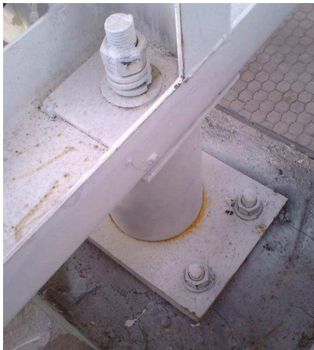
Fig. 4.17: Apoyo en casa de fuerza después de colocar pernos de anclaje 161
