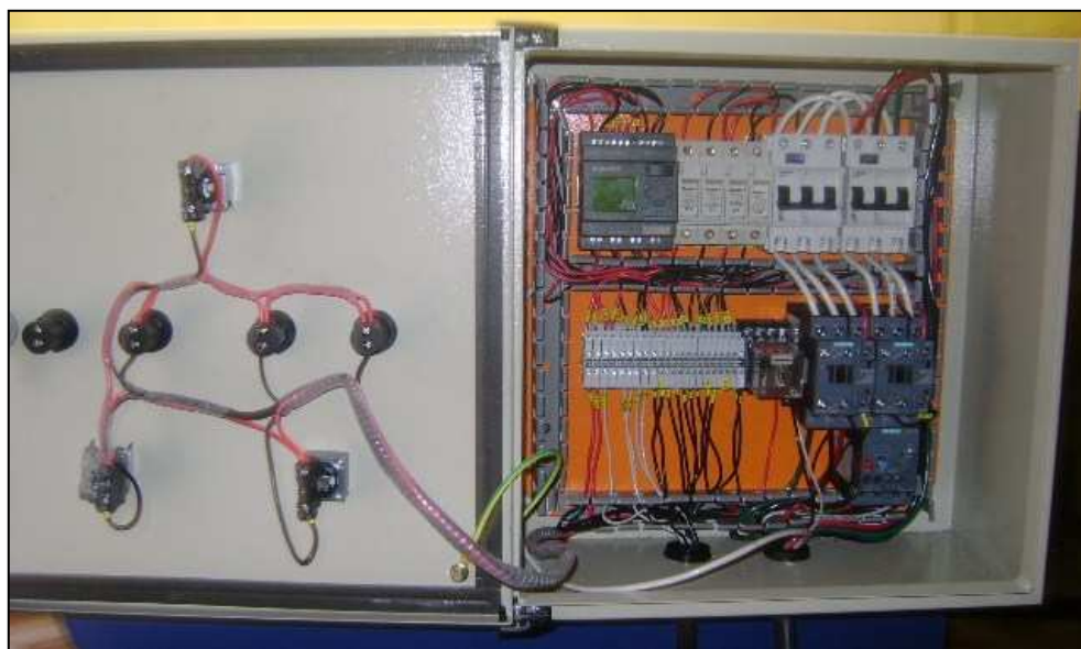
Figura 4.5. Sistema de control de la maquina
