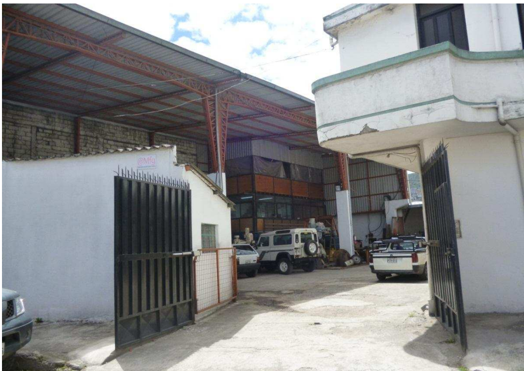
Fotografía 4.2. Instalaciones secundarias para la construcción.
