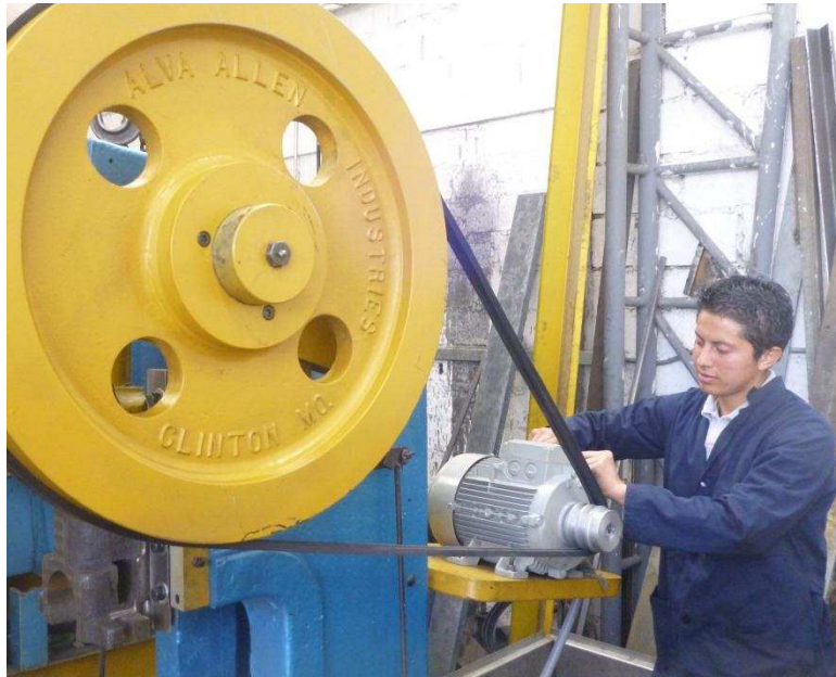
Fotografía 4.11. Montaje del motor eléctrico
