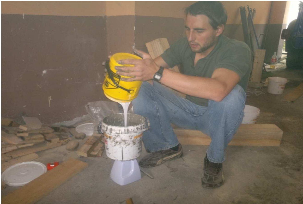
FOTOGRAFÍA 5. Añadiendo adhesivo entre las láminas
