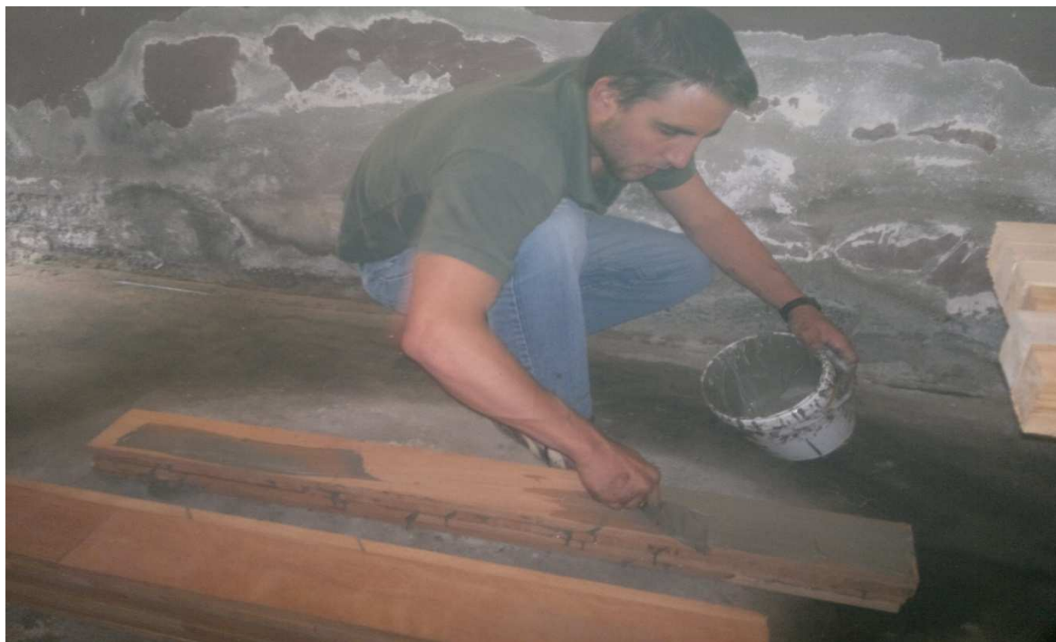
FOTOGRAFÍA 5. Añadiendo adhesivo entre las láminas
