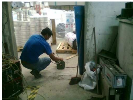
Figura 2.11 Limpieza de los motores
