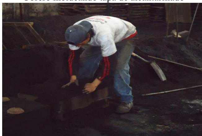
Obrero moldeando tapa de alcantarillado
