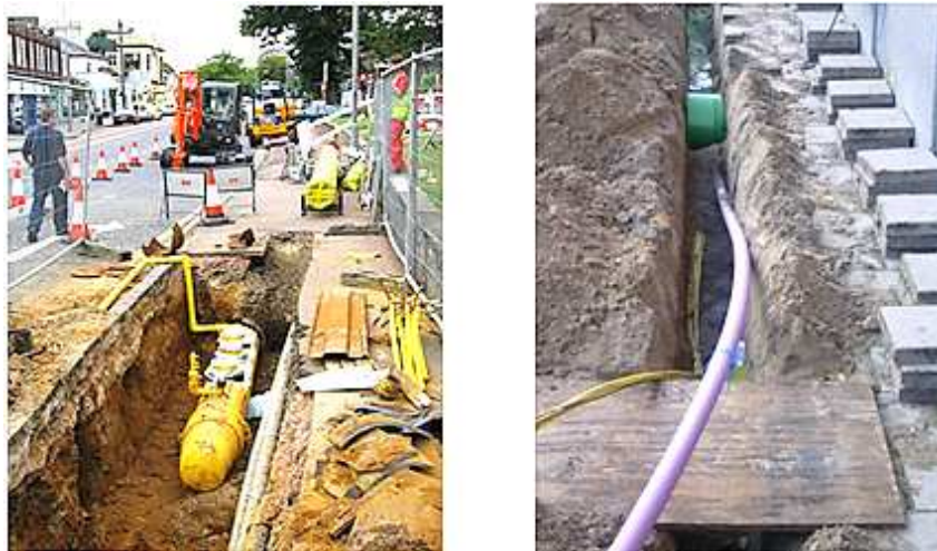
Figura 1.62: Canalización por zanjas. [43] [44]
