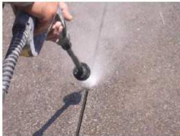
Figura 1.68: Limpieza de la microzanja con agua a presión. [9]
