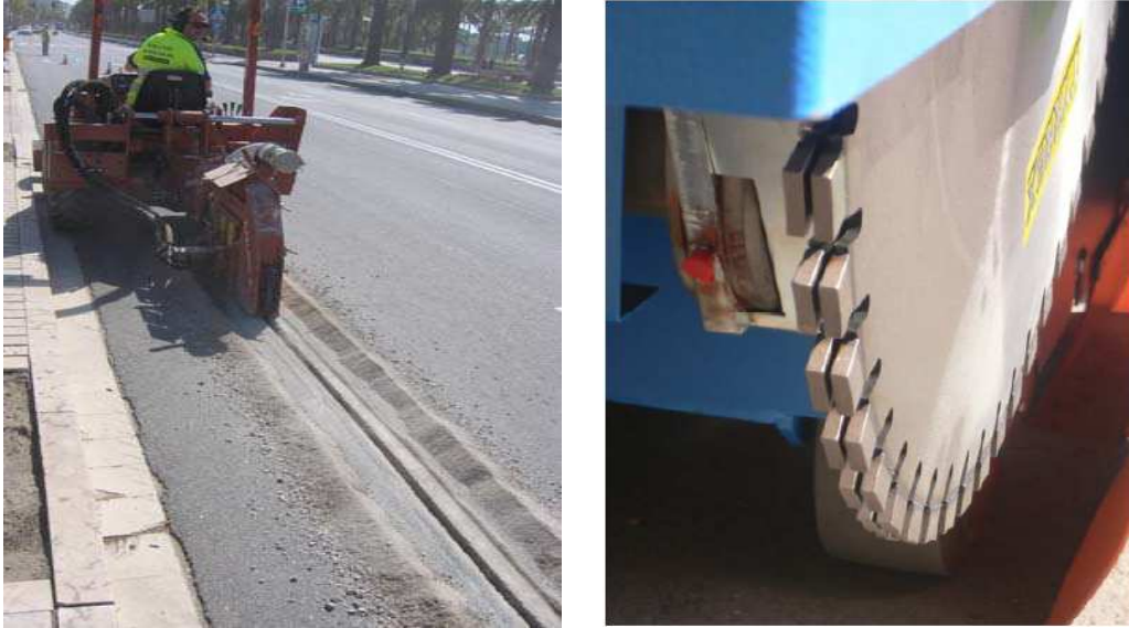
Figura 1.67: Corte del asfalto. [9] [39]
