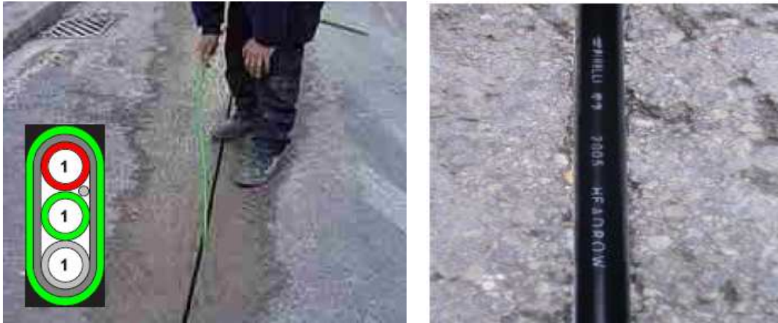
Figura 1.69: Tendido del microducto y/o del cable. [9]
