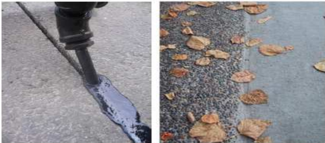
Figura 1.70: Sellado y aspecto final de la microzanja. [9] [40]
