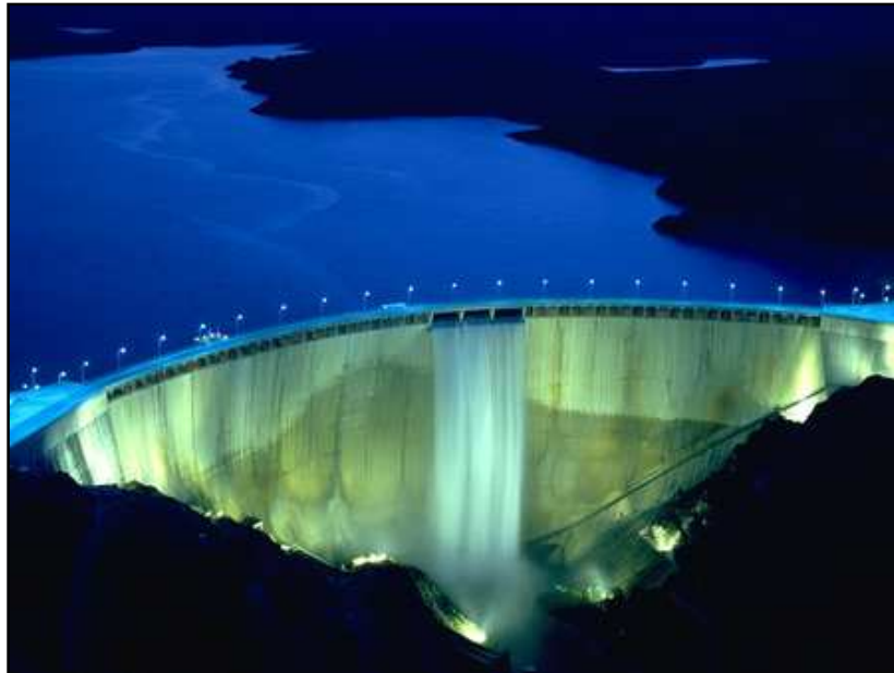
FIGURA 3.6: Presa de Atazar (Tipo Arco), Madrid-España
