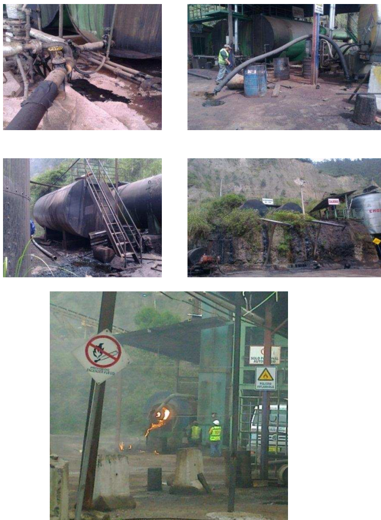
Figura 4.7. Riesgo de incendio
