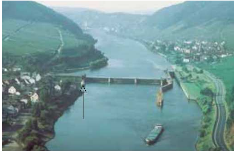
FIGURA 3.2 VISTA AÉREA DE LA PRESA EN NEEF EN EL RÍO MOSELLE (RENANIA- PALATINADO), PARA MOSTRAR EL TAMAÑO DEL PASO DE LOS PECES (FLECHA) EN COMPARACIÓN CON EL TAMAÑO TOTAL DE LA PRESA.
