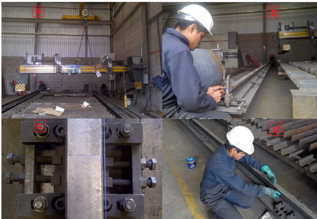
Figura 4.17 Acciones correctivas en la bancada; a) Elevación del pórtico; b) Ubicación de la guía de alineación; c) comprobación de desalineación; d) Lubricación y engrasado de las bancadas
