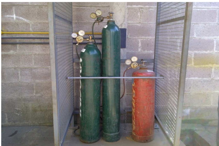
Figura 4.10 Sistema de regulación de gases
