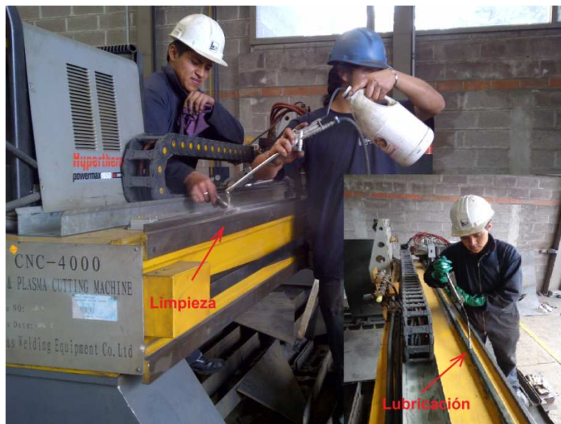
Figura 4.19 Limpieza y lubricación del pórtico
