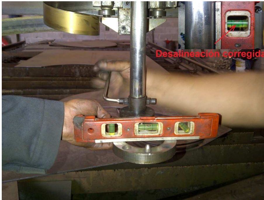
Figura 4.14 Desalineación de la antorcha corregida
